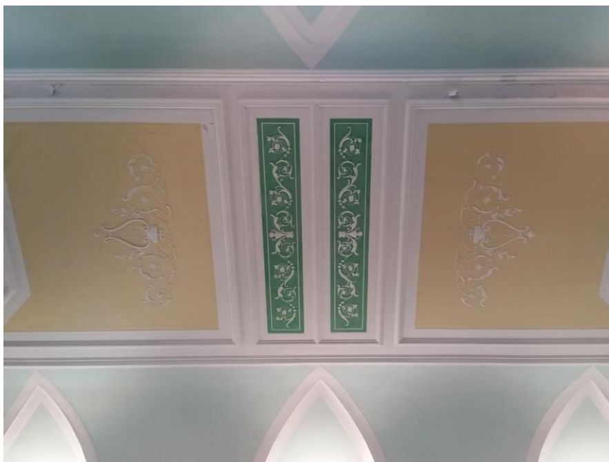
Slika 8. Detalj svoda glavnoga broda
