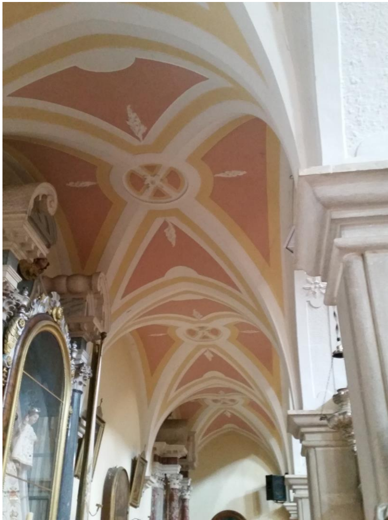
Slika 9. Svodovi bočnih brodova
