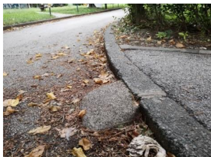
Slika 5. Nasuti beton na visokom rinzolu u zagrebačkom naselju Zapruđe. Izvor: Fotografija RD (08/09/2019)
