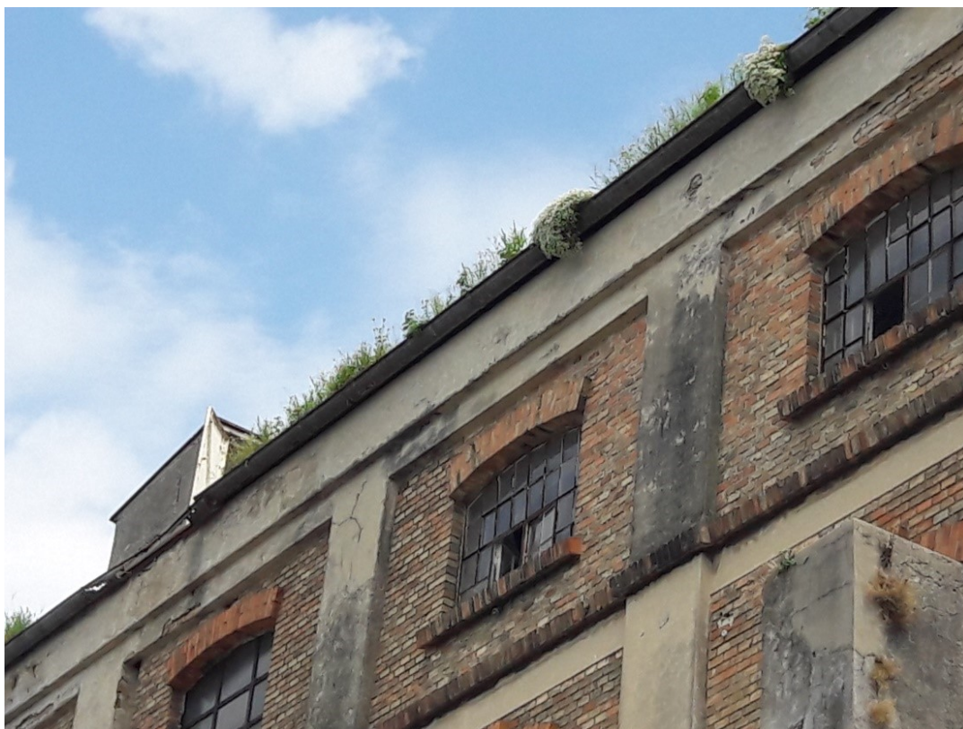
Slika 51. Detalj južnog pročelja skladišta: sustav odvodnje oborinskih voda
