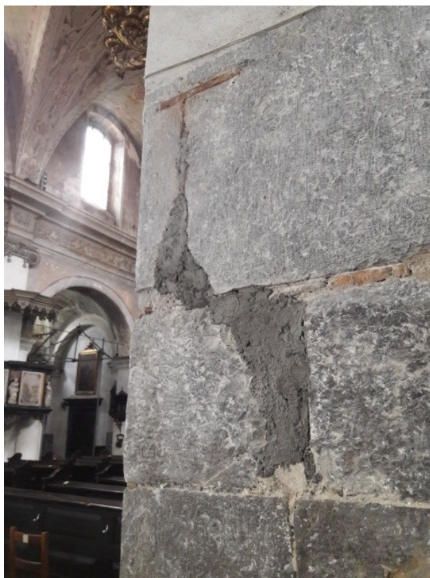
Slika 24. Primjer intervencije na stubu južnog broda
