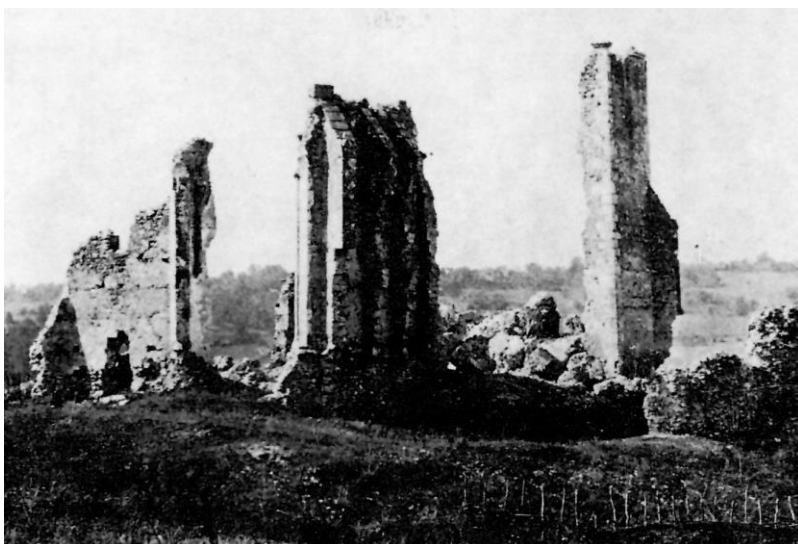
Sl. 15 Pogled na ostatke zidova svetišta samostanske crkve u Bijeloj
