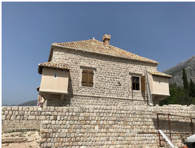
3. Knežev dvor u Pridvorju u fazi obnove, snimljeno 2019.
