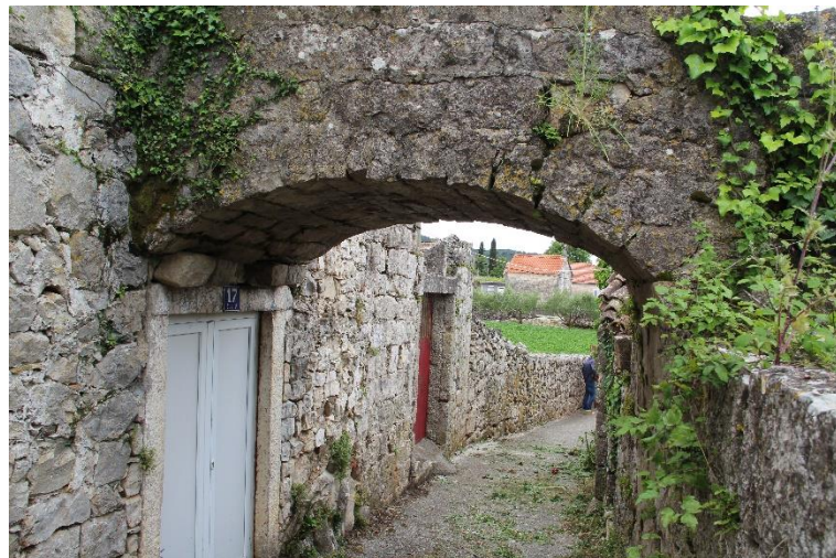
18. Volat između nekadašnje gospodarske građevine i konjušnice kompleksa Kabužić, Čilipi
