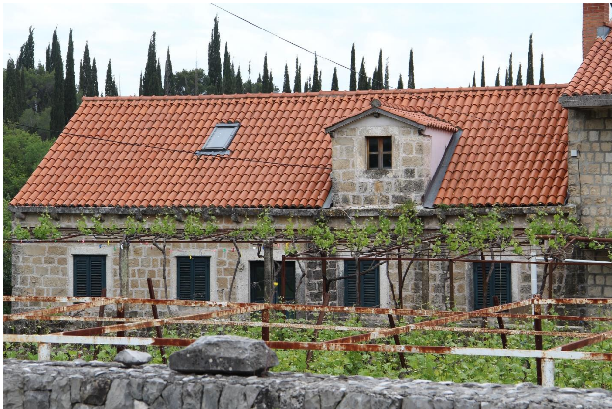
46. Pročelje stambene građevine kompleksa Bunić, Čilipi, snimljeno 2019.
