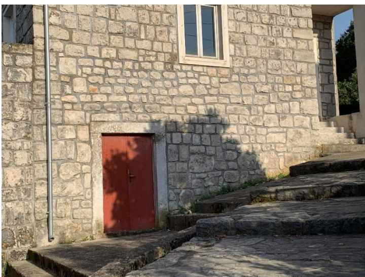
12. Prizemlje građevine kompleksa Zamanja Crijević, Gruda, snimljeno 2019.
