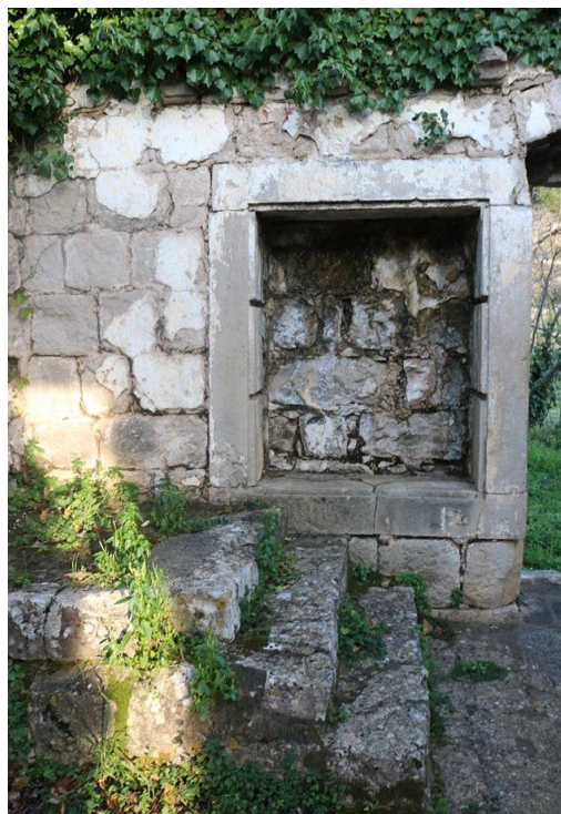
68. Kameni ormar i ostaci kamenog stepeništa, kompleks Crijević, Radovčići
