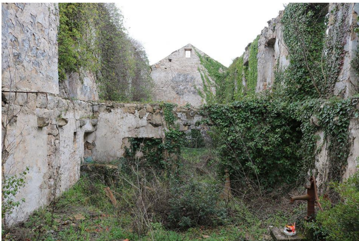
29. Unutrašnjost jednokatnice kompleksa Pucić, Čilipi, snimljeno 2019.
