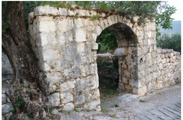
98. Ogradni zid i portal kompleksa Božidarević, Lovorno, snimljeno 2019.
