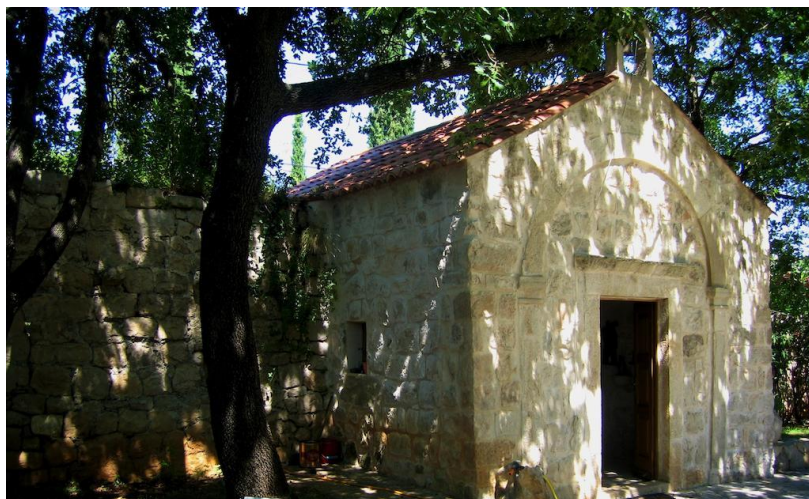
22. Kapelica sv. Antuna, kompleks Kabužić, Čilipi (Miočići) poslije obnove, kraj 20. stoljeća
