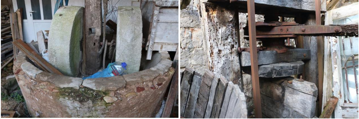
69. i 70. Ostaci mlinice u gospodarskoj zgradi kompleksa Crijević, Radovčici
