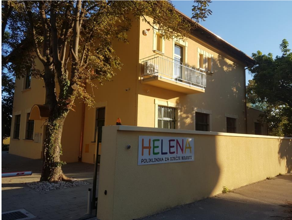
Slika 17. Zgrada poliklinike Helena (sjeveroistočna strana)
