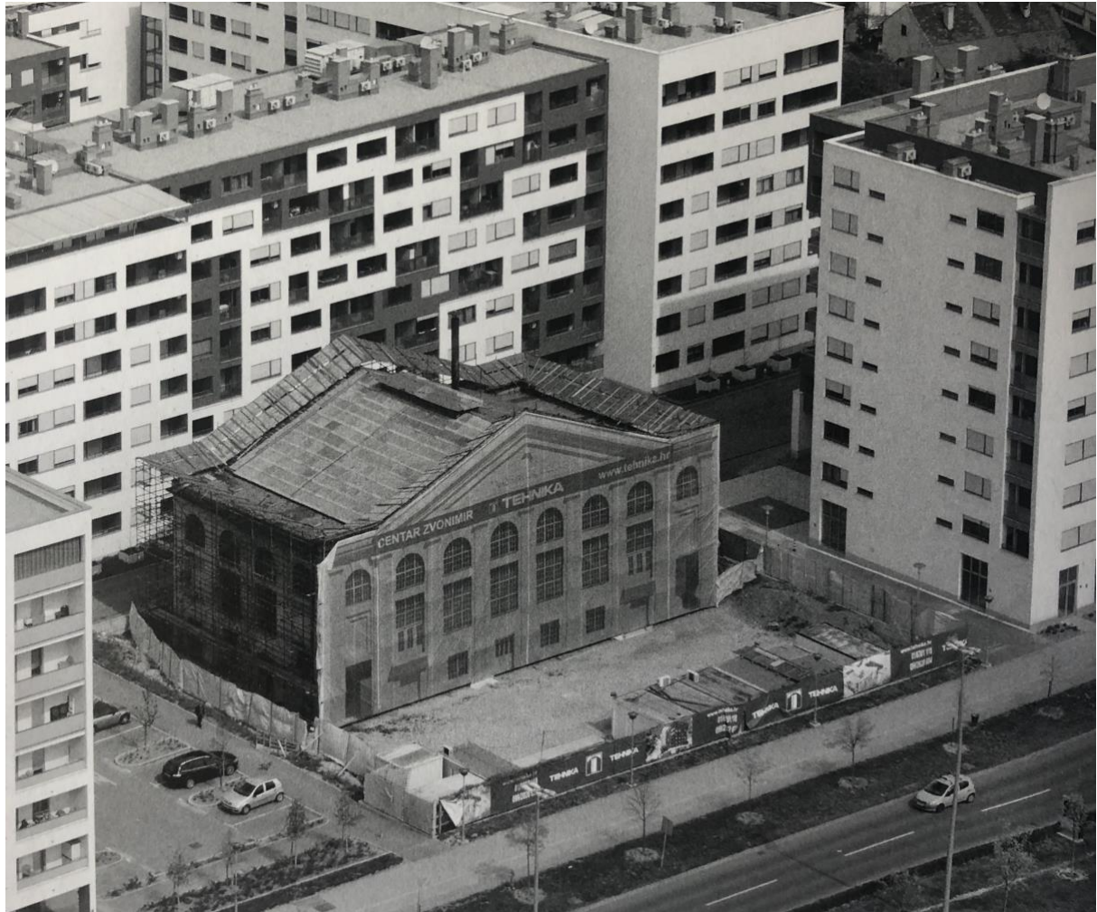
Slika 26. Zgrada strojarnice i kotlovnice Prve hrvatske tvornice ulja, stanje iz 2012.
