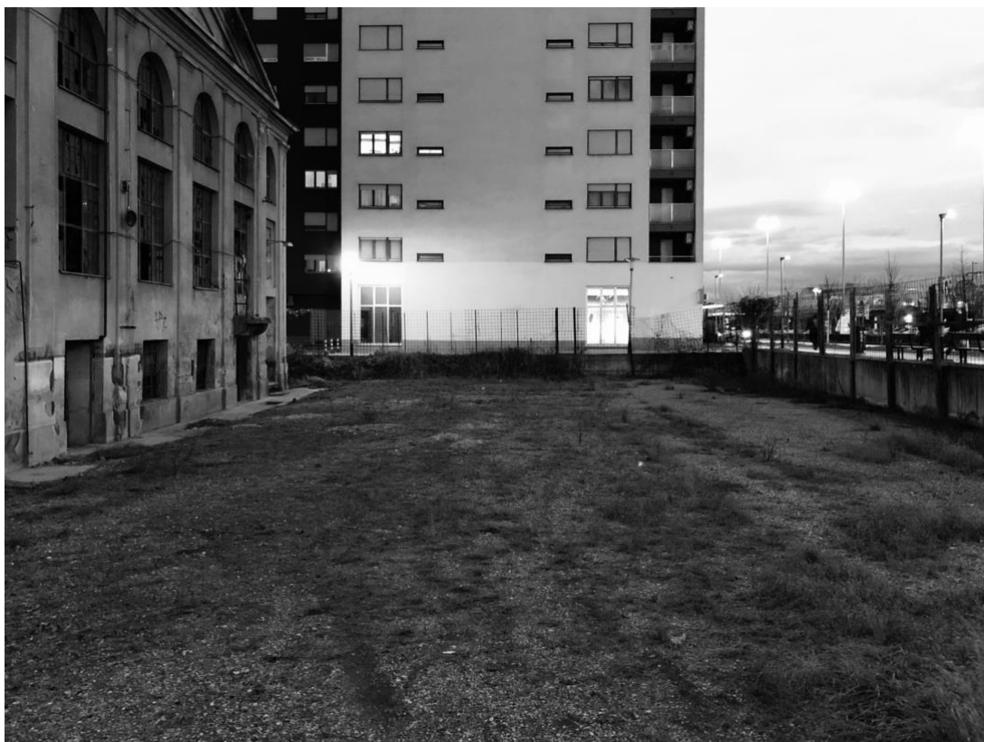
Slika 40. Prazna površina ispred zgrade kotlovnice i strojarnice, stanje iz siječnja 2020.
