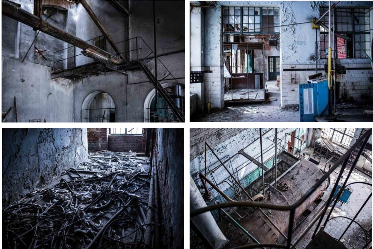
Slika 31.,32., 33., 34., 35. Stanje unutrašnjosti zgrade kotlovnice i strojarnice iz 2015. (foto: Bojan Haron Markičević)
