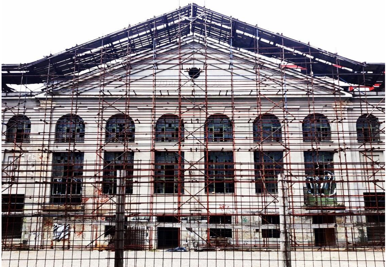
Slika 14. Zgrada kotlovnice i strojarnice prije skidanja skela, ožujak 2018. (foto: Iva Neljak)
