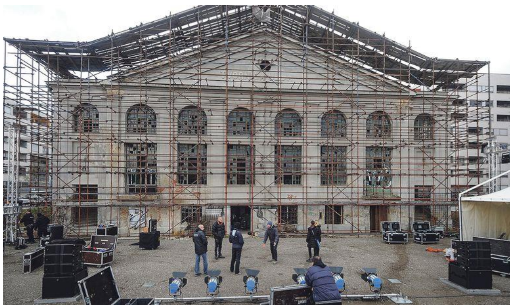
Slika 47. Pripreme za produkciju opere za djecu Brundibár na prostoru ispred glavnog pročelja zgrade kotlovnice i strojarnice u siječnju 2018 godine (foto: Damir Krajač)
