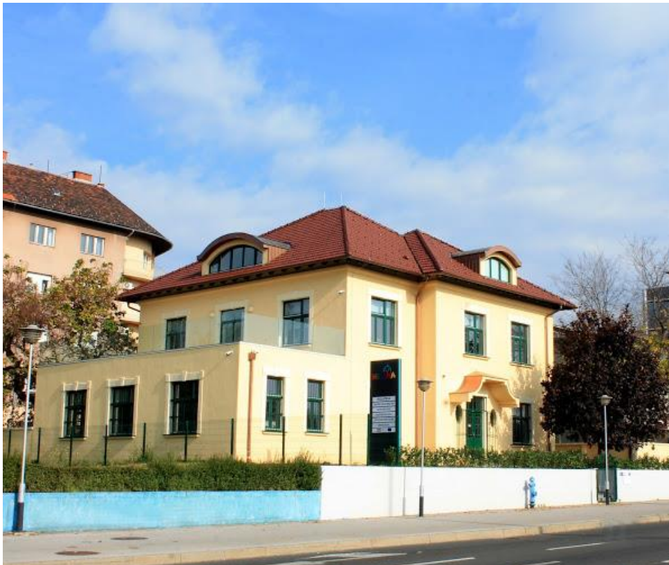
Slika 18. Zgrada poliklinike Helena (jugozapadna strana)
