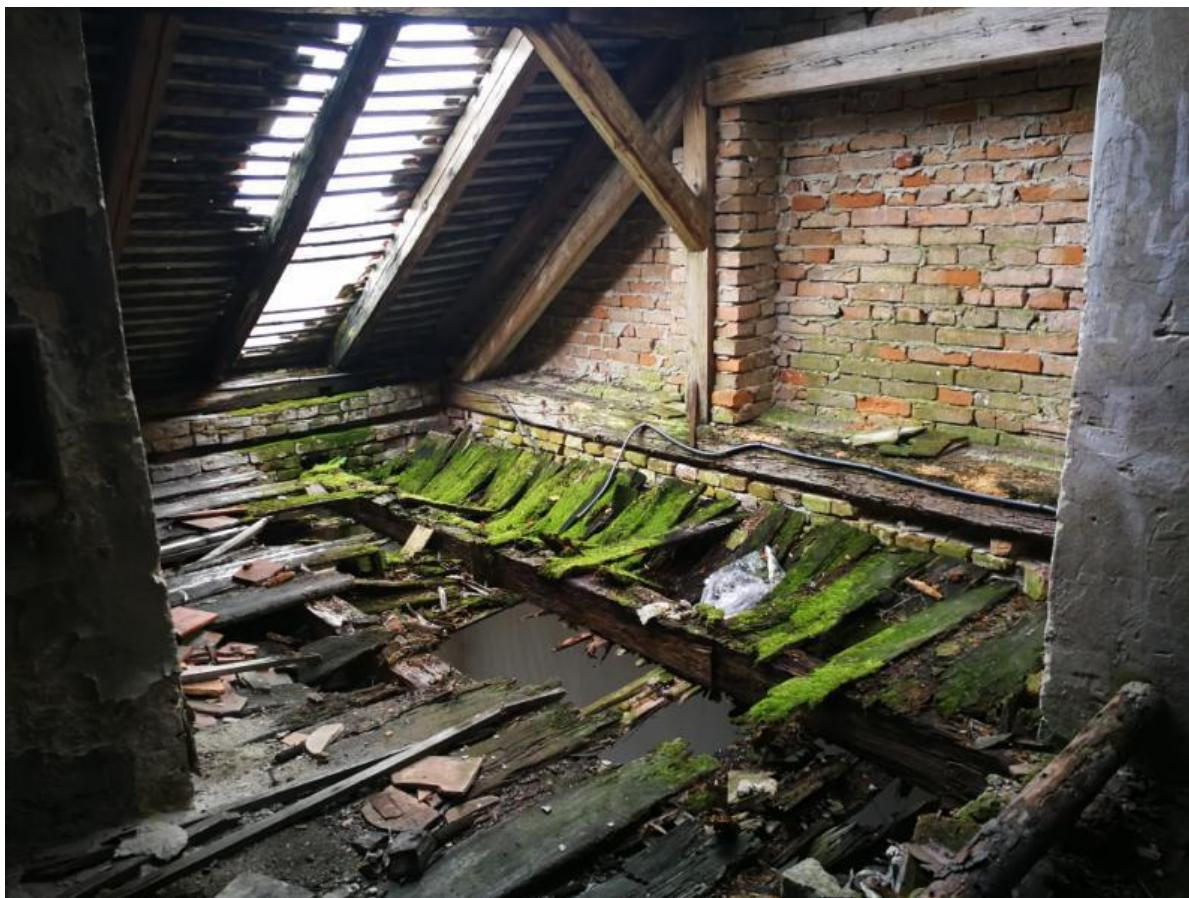
**Slika 2. Uništen krov i tavanski pod na jednom od objekata, uzrokovano prokišnjavanjem i nemarom**
