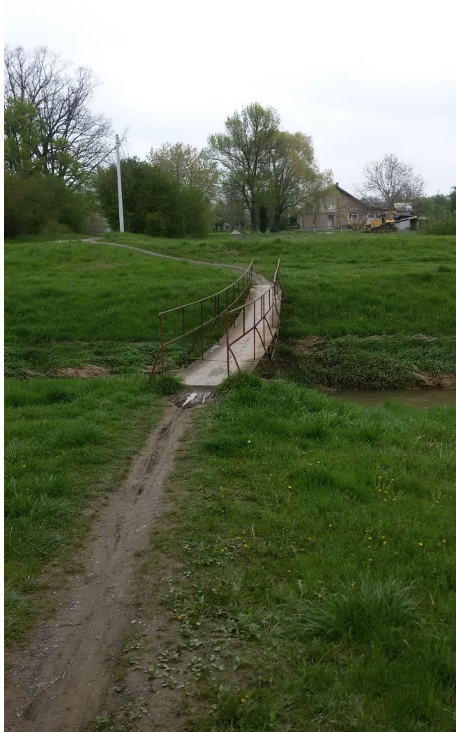
Slika 42. Željezni pješački most na mjestu nekadašnjeg drvenog mosta
