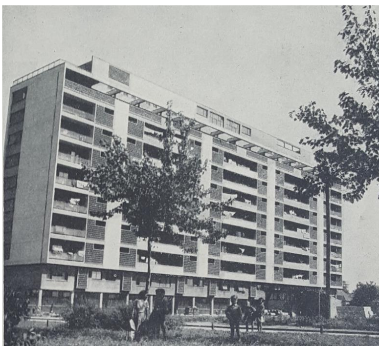
Slika 12. Začelje stambene zgrade Božidara Rašice, Ulica grada Vukovara 62a-d 235
