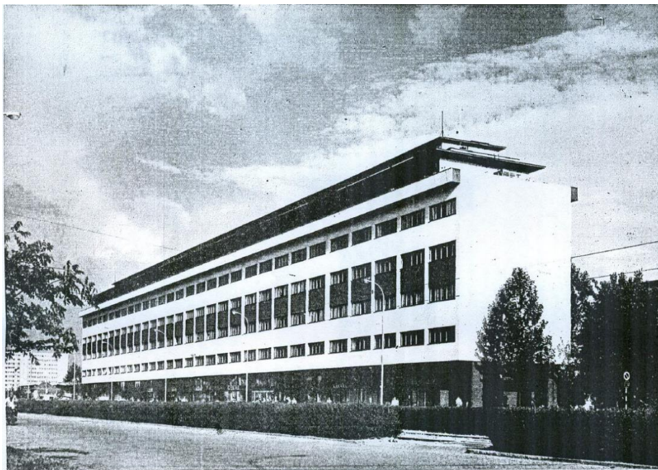
Slika 47. Pročelje uredske zgrade Nevena Šegvića, Ulica grada Vukovara 56-60 289
