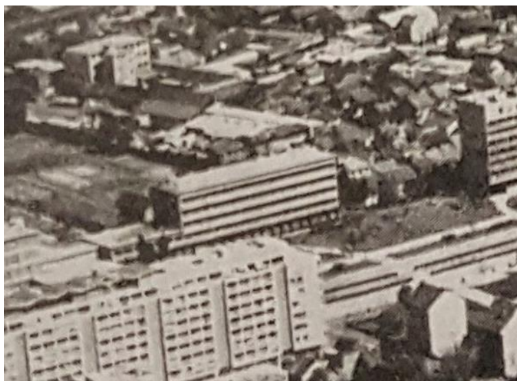
Slika 1. Sklop upravnih zgrada MUP-a RH 214
