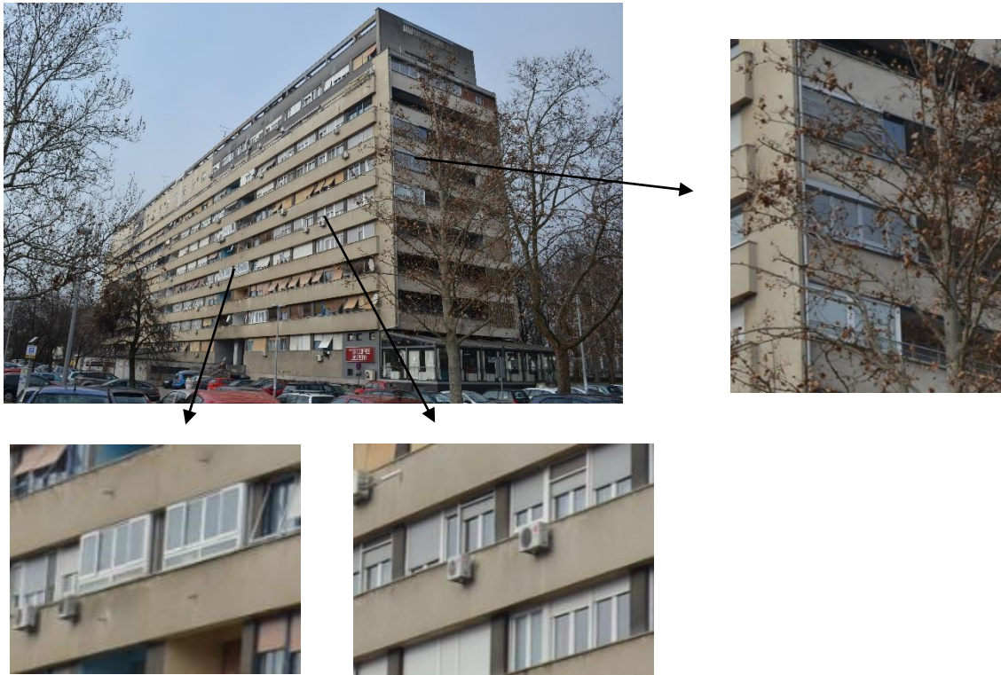
Slika 30. Začelje višestambene zgrade Kruge, Ulica grada Vukovara 222-224 261
