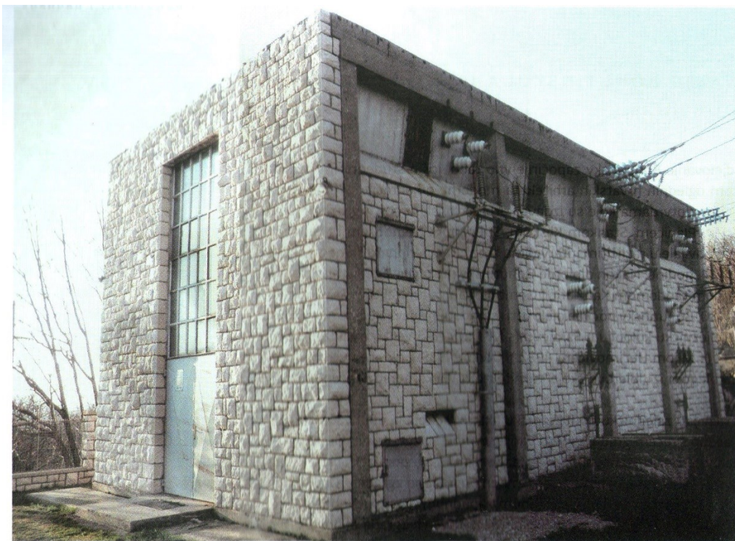
Juraj Denzler und Gustav Bohutinsky, typisiertes Umspannwerk TS-300, Plase in der Nähe von Rijeka, 1946, Foto: Nataša Jakšić
