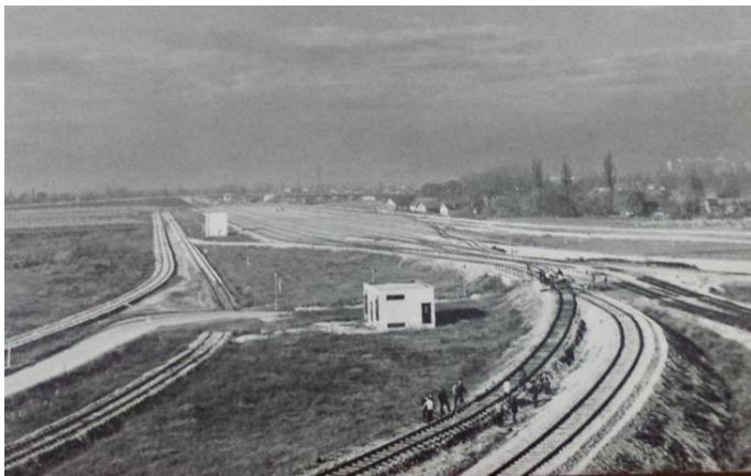
Prilog 26. Ranžirni kolodvor u doba izgradnje, preuzeto iz: Brošura Zagreb Ranžirni kolodvor 1978-2003. (Bunijevac, 2003: s.p.)
