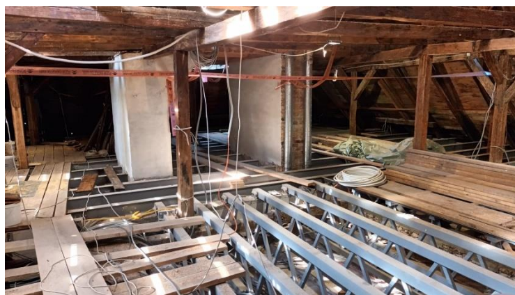
Slika 39. Potkrovni prostor u ranijem stadiju restauracije, čelična podna konstrukcija poda je vidljiva.
