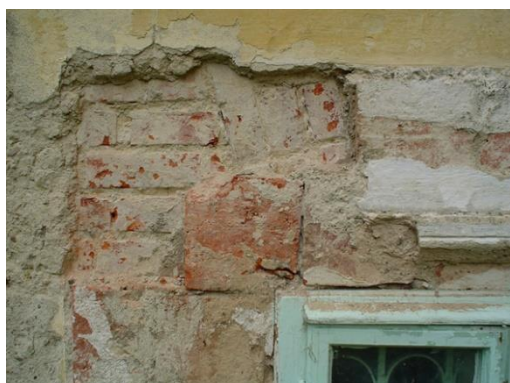
Slika 41. Sondiranje prozorskih otvora prizemlja 2004.
