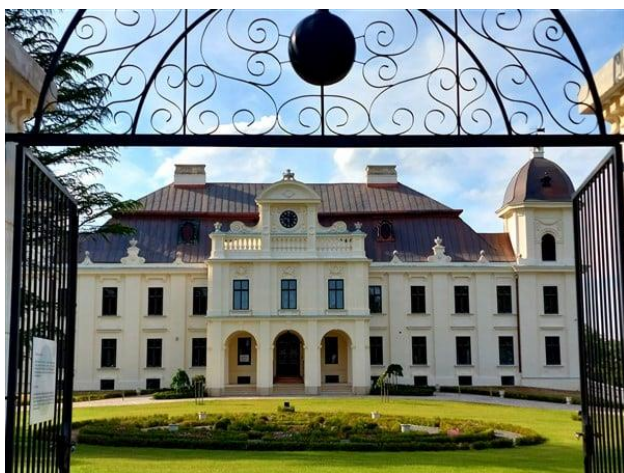
Slika 40. Pročelje Velikog dvorca nakon restauracije
