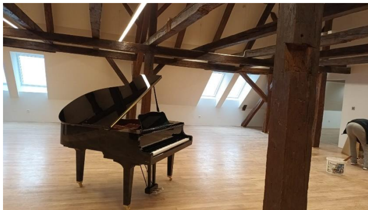
Slika 38. Potkrovni prostor adaptiran u medijsku dvoranu u zadnjim stadijima restauriranja, vidljiv je dio otvorene krovne konstrukcije.
