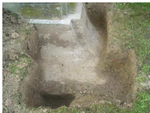
Slika 42. Sondiranje sjeverozapadnog ugla istočnog rizalita 2004.
