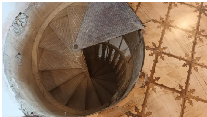
Slika 37. Rekonstrukcija spiralnog metalnog stubišta koje spaja istočni salon u prizemlju sa suterenom.
