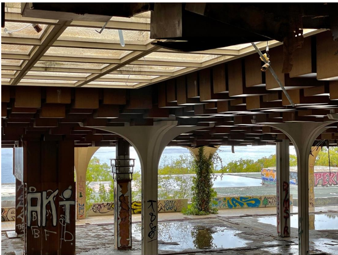
Sl. 14. Detalj kasetiranog stropa i krovnih prozora
