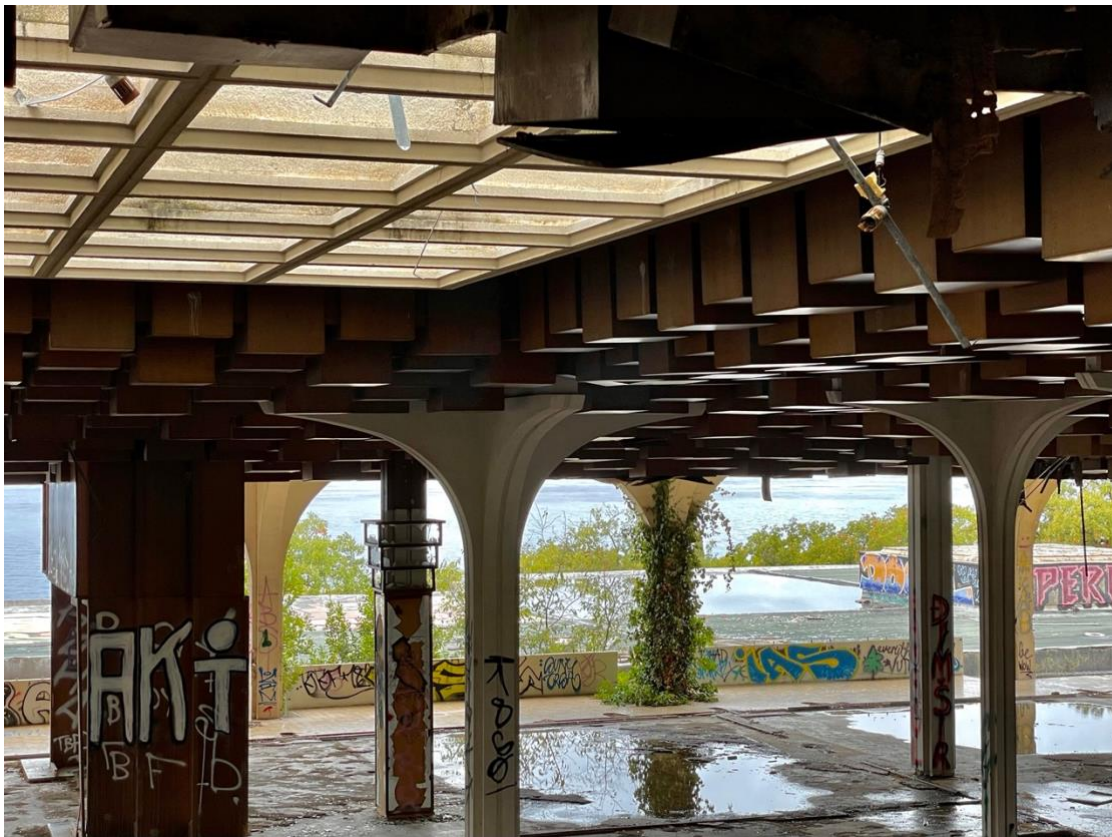
Sl. 14. Detalj kasetiranog stropa i krovnih prozora
