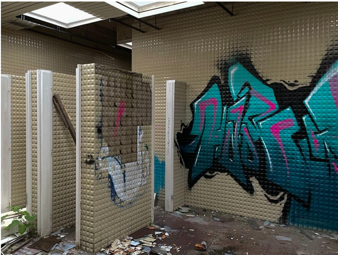
Sl. 18. Prostor tuševa i sauna kod unutarnjeg bazena
