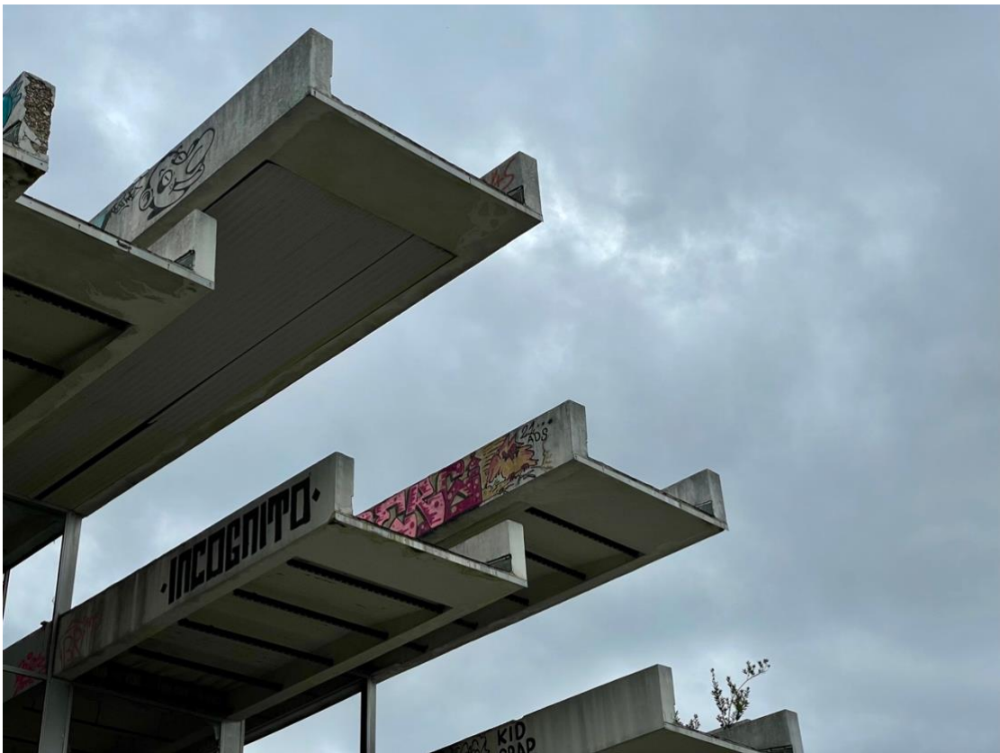
Sl. 26. Detalj armiranobetonske konstrukcije iznad vanjskog bazena
