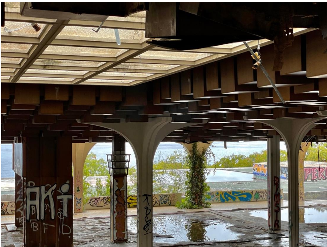
Sl. 14. Detalj kasetiranog stropa i krovnih prozora
