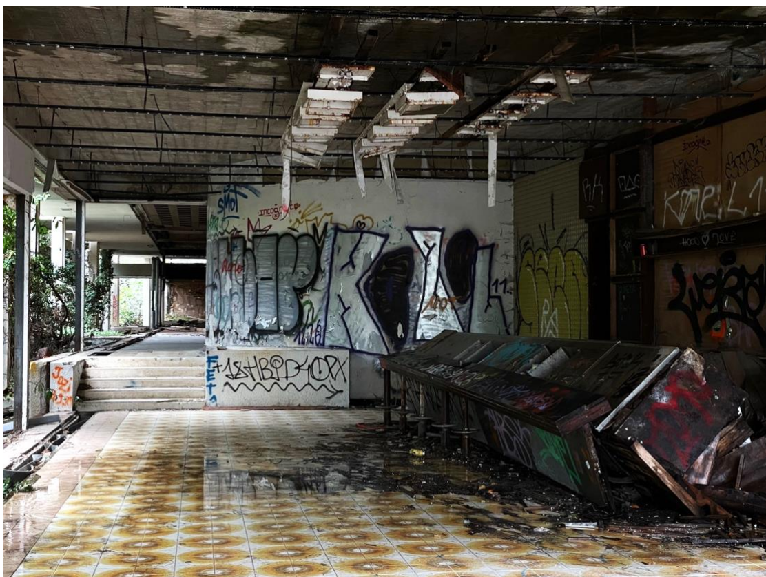
Sl. 20. Bar kod unutarnjeg bazena
