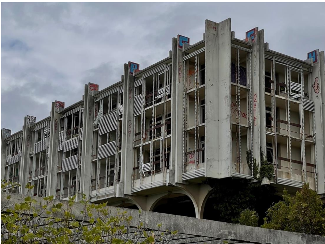
Sl. 24. Hotel Palace – detalj nekadašnjih pomičnih brisoleja
