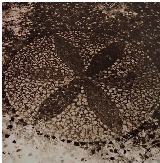
Slika 5: Terrazzo pod na prvom katu kuće Šain
