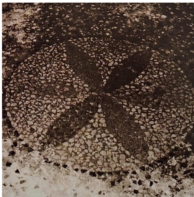
Slika 5: Terrazzo pod na prvom katu kuće Šain
