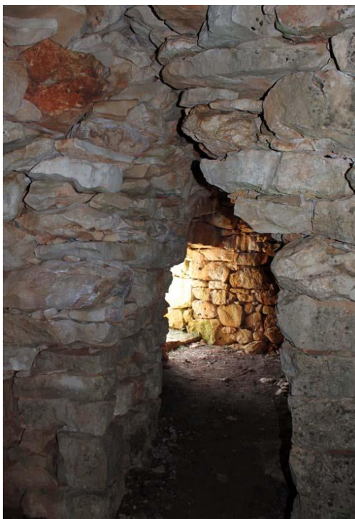
Slika 77: Nepravilno svođeni prolaz
