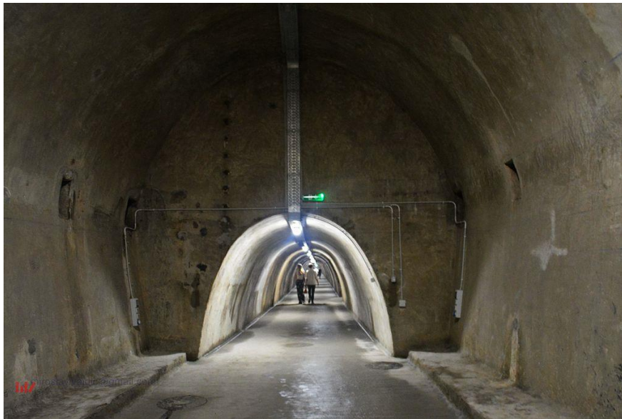
Slika 1. Tunel Grič, pogled iz središnje dvorane
