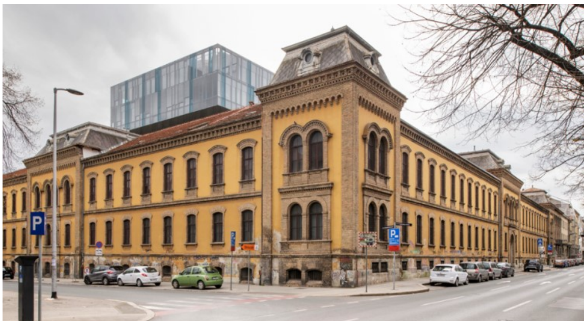
Slika 1. Pogled na zgradu nekadašnje Tvornice duhana u Zagrebu i zgradu firme Adris u pozadini (stakleni volumen).
