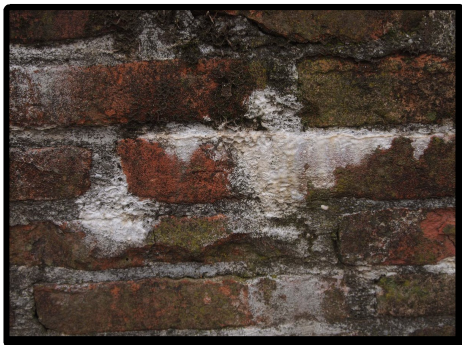
25 – detalj vanjske strane južnog dijela zidina, bijele staklaste nakupine; stanje u ožujku 2024. (snimio: F. Jajčinović)
