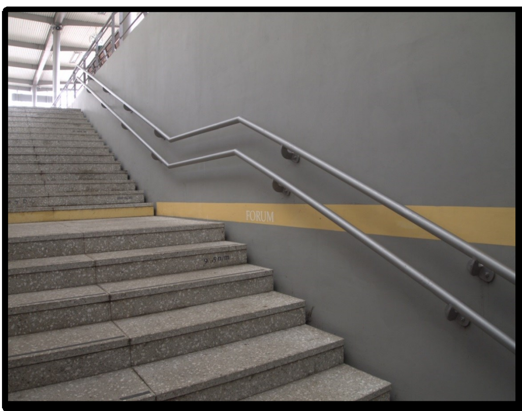
51 – zapadno stubište pothodnika; žuta horizontalna linija svjedoči o razini tla na kojoj su pronađeni ostatci forumskog popločenja (snimio: F. Jajčinović)
