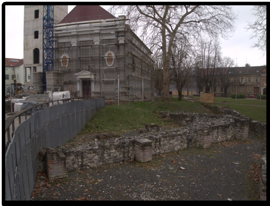
5 - sjeverozapadni zid žitnice s kontraforima; ožujak 2024. (snimio: F. Jajčinović)
