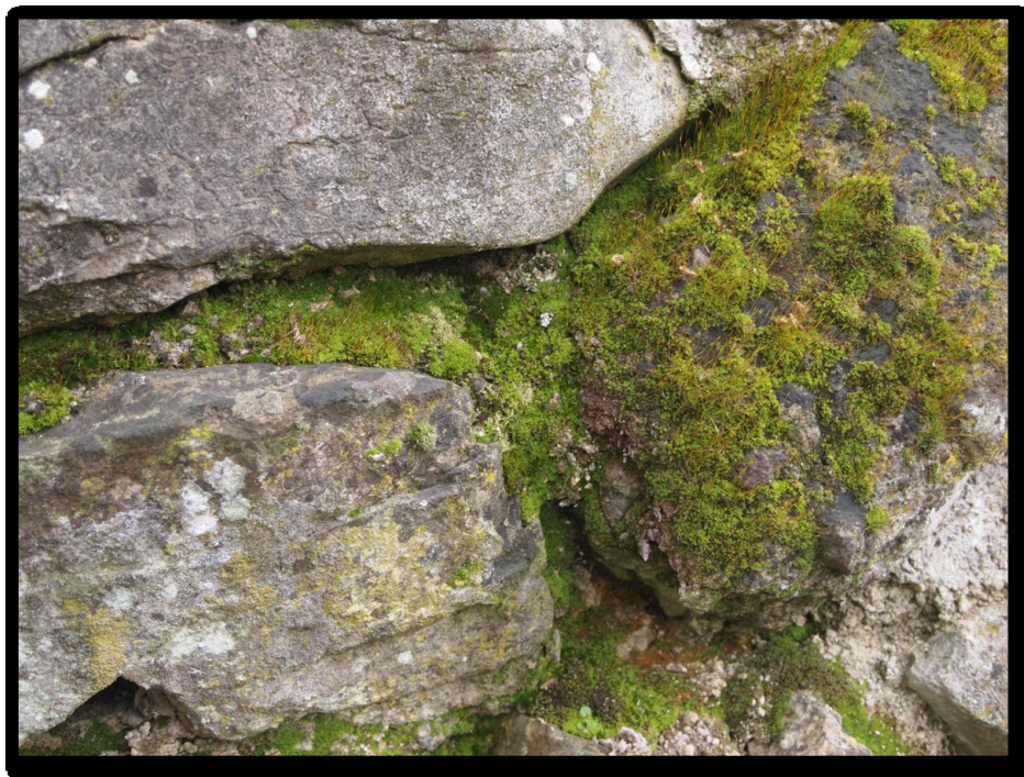
23 – detalj unutrašnje strane južnog dijela zidina, naslage mahovine; stanje u ožujku 2024. (snimio: F. Jajčinović)
