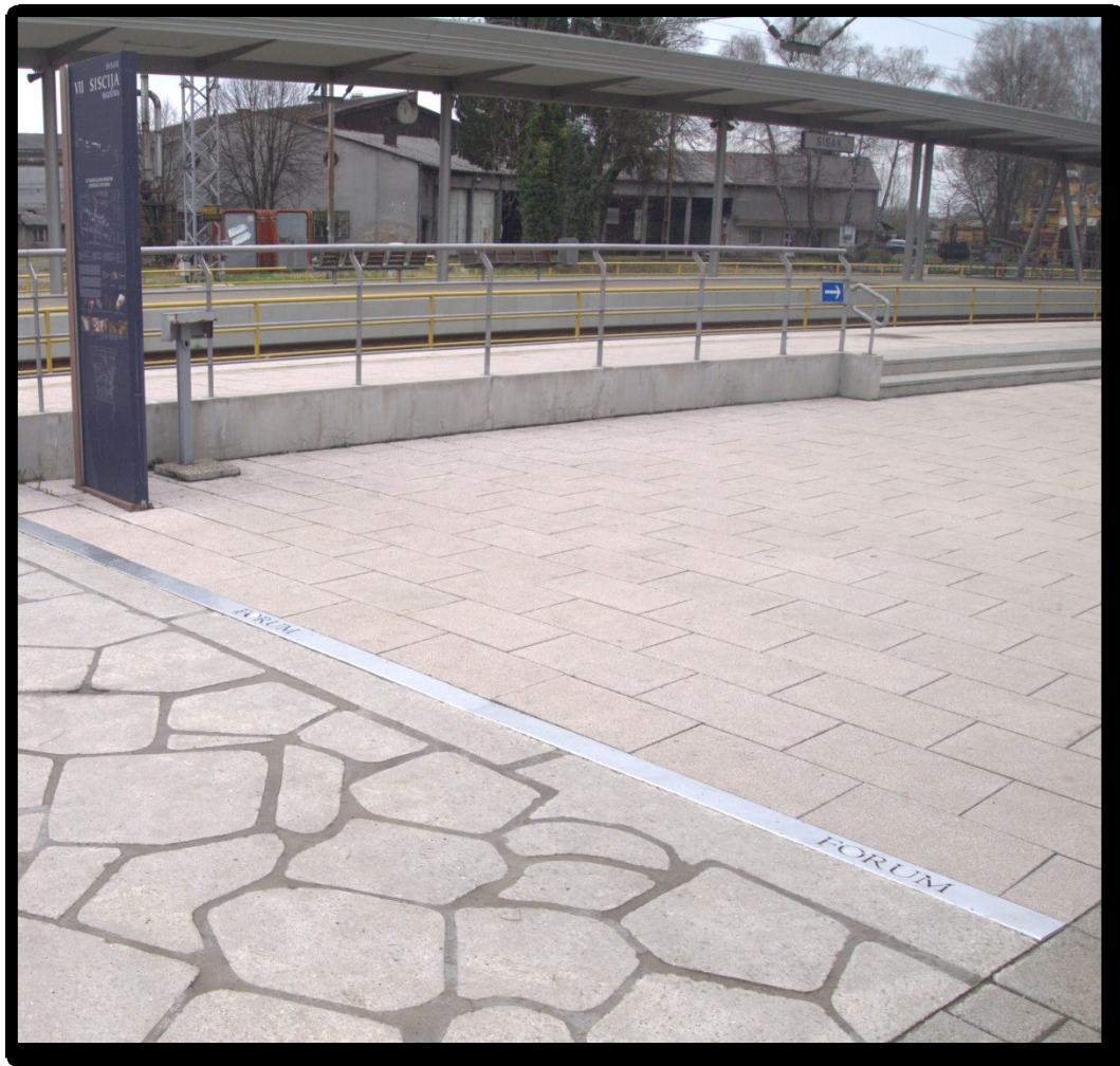
56 – metalna traka s natpisom FORUM razgraničava rekonstrukcije popločenja glavne gradske ulice (lijevo) i foruma (desno) (snimio: F. Jajčinović)
