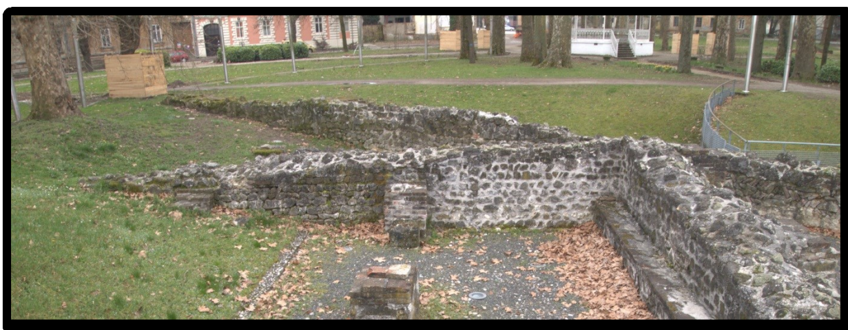
6 – jugoistočni zid žitnice s kontraforima; ožujak 2024. (snimio: F. Jajčinović)
