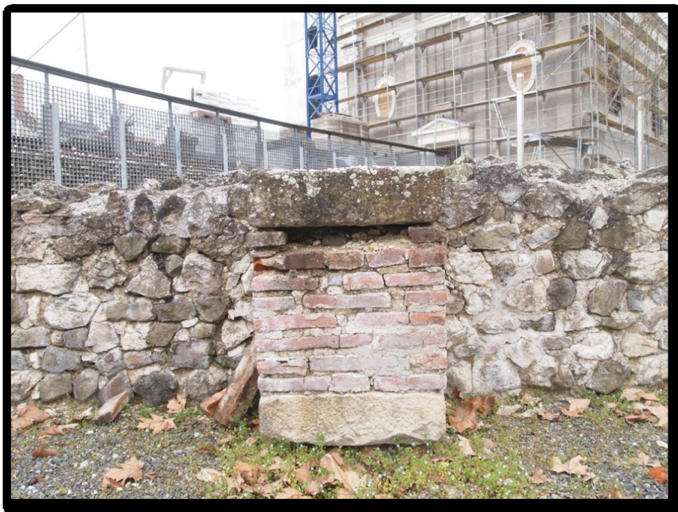
16 – Kontrafor s vanjske strane SZ zida žitnice; stanje u ožujku 2024. (snimio: F. Jajčinović)
