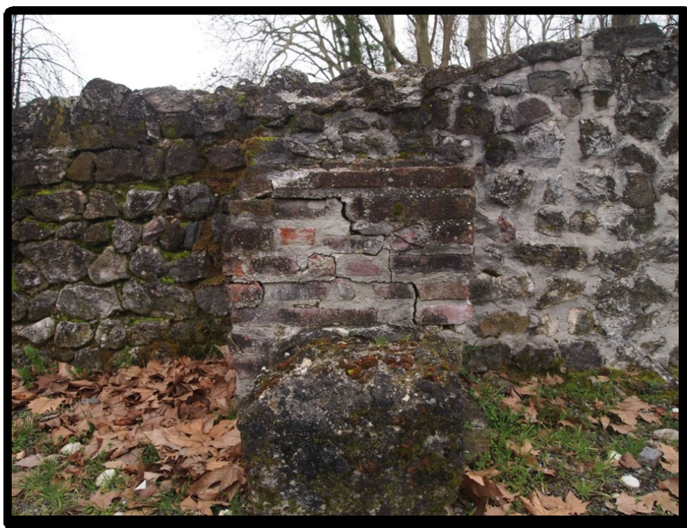
17 - Kontrafor s unutrašnje strane JI zida žitnice; stanje u ožujku 2024. (snimio: F. Jajčinović)
