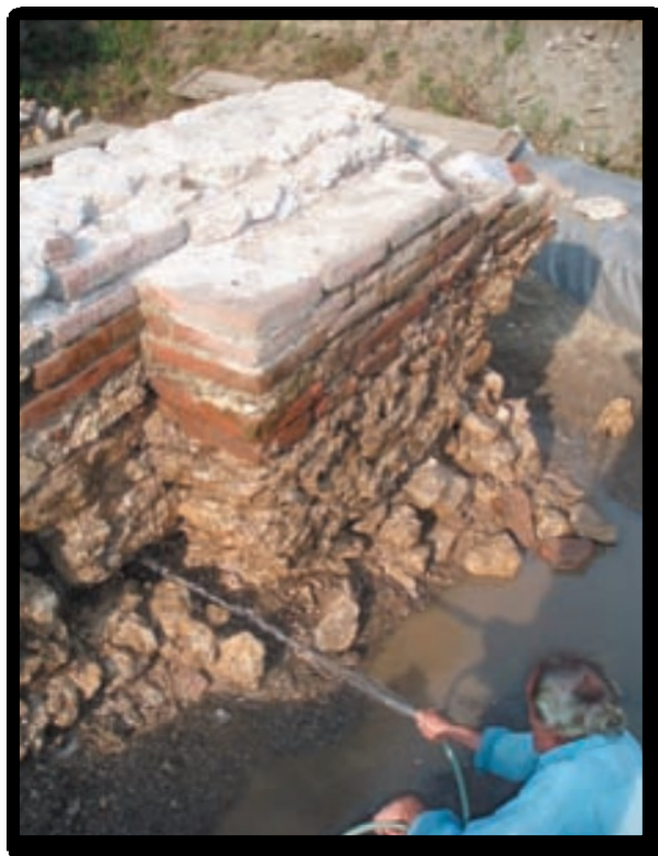
42 – ispiranje temeljne zone portala/trijumfalnog luka (preuzeto iz: Lolić 2006., str. 205.)
