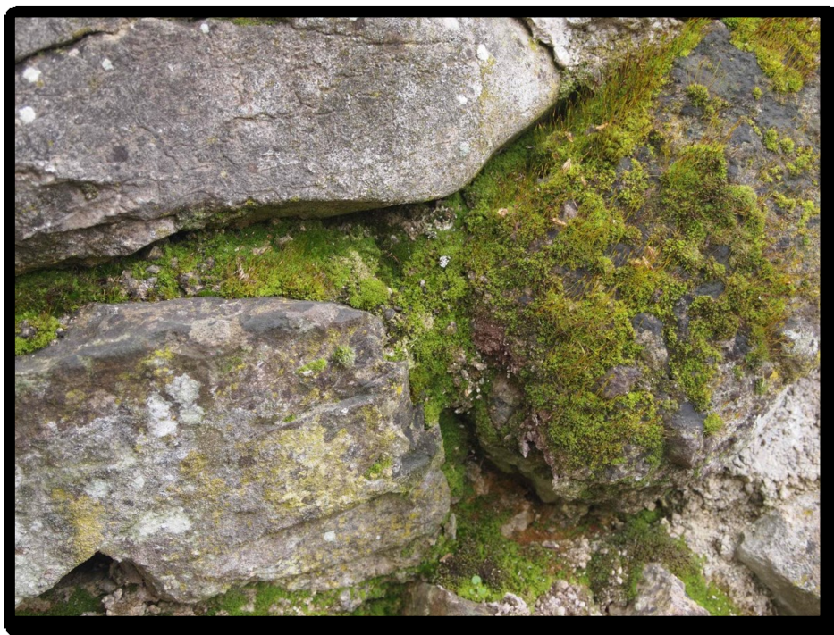
23 – detalj unutrašnje strane južnog dijela zidina, naslage mahovine; stanje u ožujku 2024. (snimio: F. Jajčinović)
