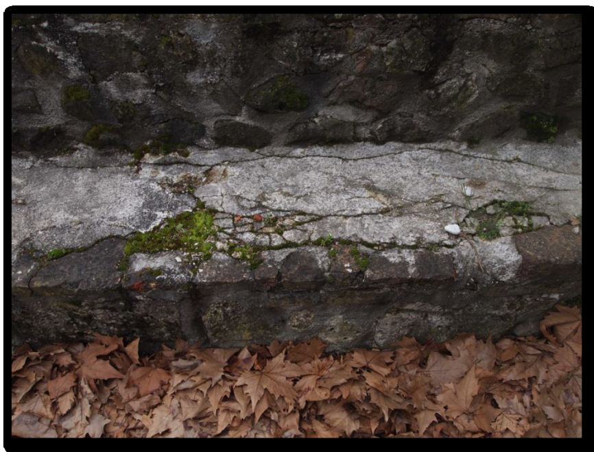
20 – raspadajući zaštitni sloj opečne klupe; stanje u ožujku 2024. (snimio: F. Jajčinović)
