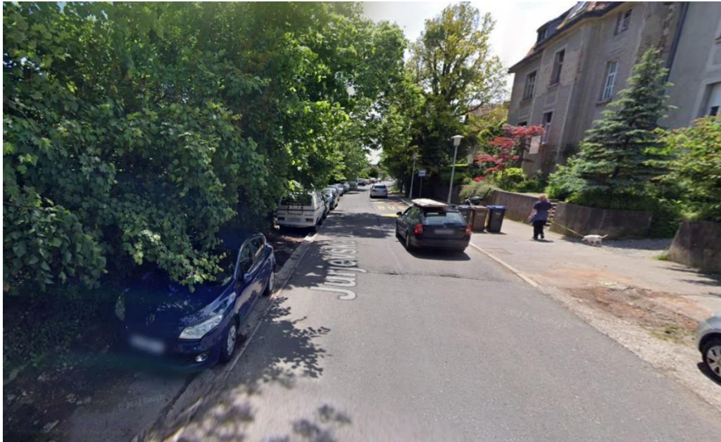
Sl. 21. Parkiranje uz cestu na Jurjevskoj, s lijeve strane fotografije, prostor klizišta (preuzeto s Google maps: https://www.google.com/maps (pristup: 20.12.2023))
