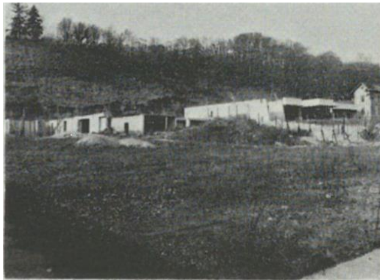
Sl. 5. Temelji hotela nakon obustave gradnje 1972., slikano s jugoistoka (Juračić 1984)
