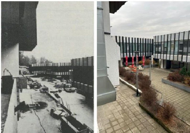
Sl. 9. Usporedba poslovnog prostora na 1. katu 1984. (vrijeme gradnje) (lijevo, Juračić 1984) i danas (autorska fotografija, 2023)
