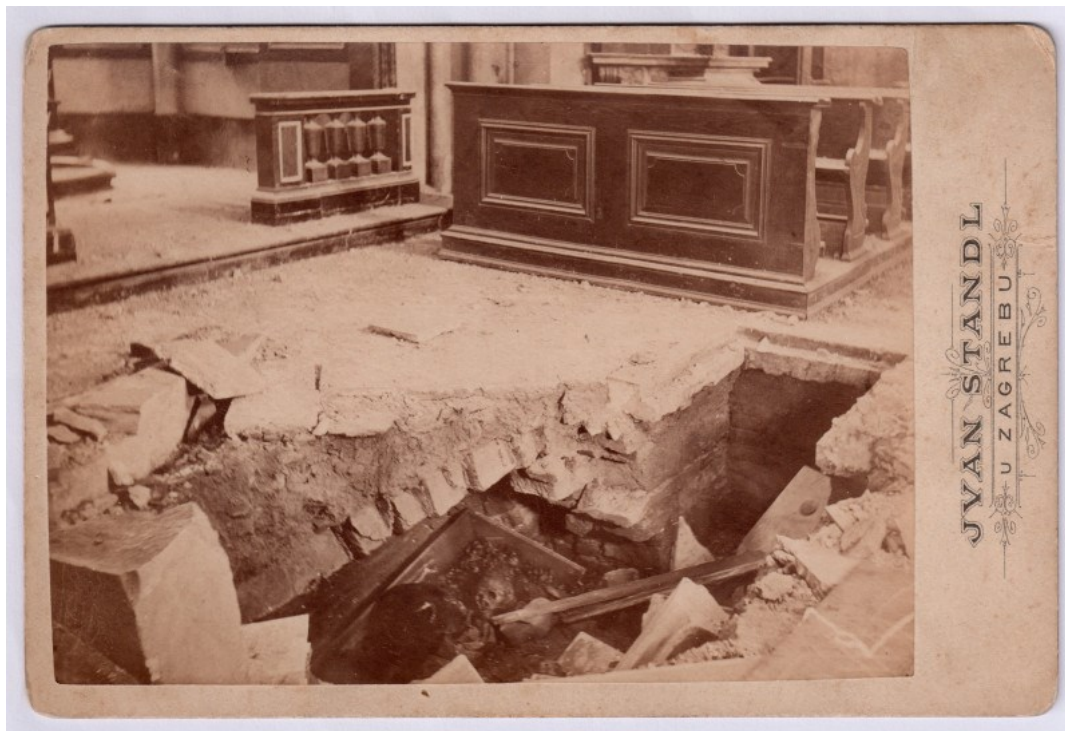
Slika 8. Potres u Zagrebu 1880. - oštećenje u katedrali
