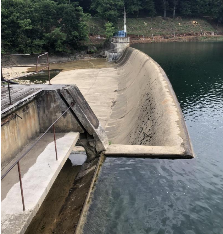
Slika 29 - Betonska brana na Mrežnici između Inzla unutar tvornice i desne obale Mrežnice, svibanj 2023. (snimila: Marija Jurić, 2023.)
