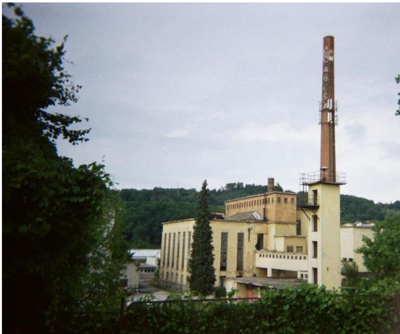
Slika 52 - Pogled na dimnjak u sklopu "Pamučne industrije Duga Resa", svibanj 2023. (snimila: Marija Jurić, 2023.)
