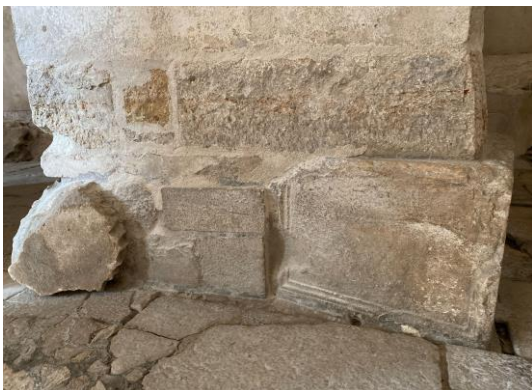
Slika 49. Kanelirani stup i dio stele u temelju petog pilona rotunde Sv. Donata. Foto: Hana Buntak
