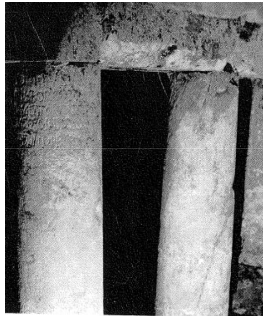
Slika 17. Spolija s natpisom u službi potpornog kamena za lepezasti svod batisterija episkopalnog kompleksa u Zadru, vidi u: Ćiril Metod Iveković, Krstionica kod Crkve Sv. Stošije u Zadru i vrijeme građenja njezina i Crkve Sv. Donata, 1937., str. 8.
