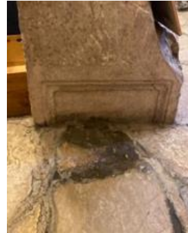
Slika 65. Temelj pilona crkve Sv. Petra Starog – sjeverna strana. Foto: Hana Buntak
