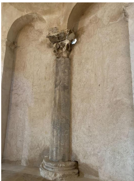
Slika 63. Lijevi stup s kapitelom zazidanog dvostrukog prolaza na galeriji rotunde Sv. Donata. Foto: Hana Buntak
