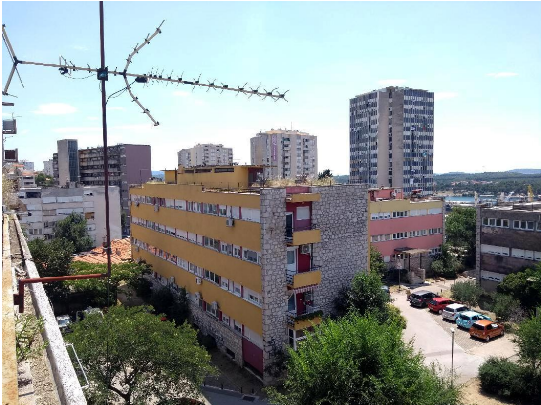
Slika 13 Vitićeva stambena zgrada u četvrti Baldekin
