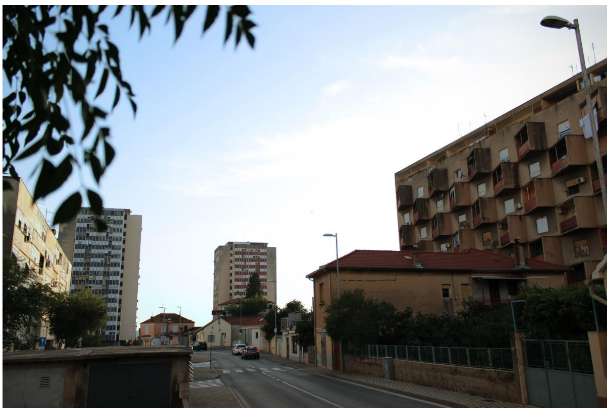
Slika 18 Pogled na prvu šibensku šestokatnicu i Crveni i Plavi neboder, kolovoz, 2023.
