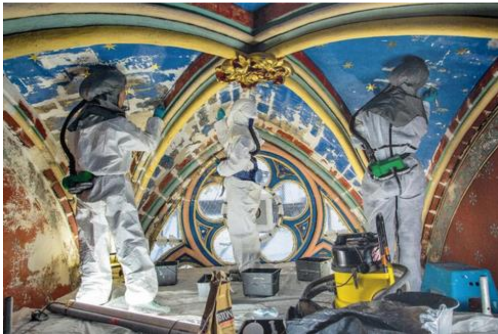
Slika 61. Radovi na kapeli
