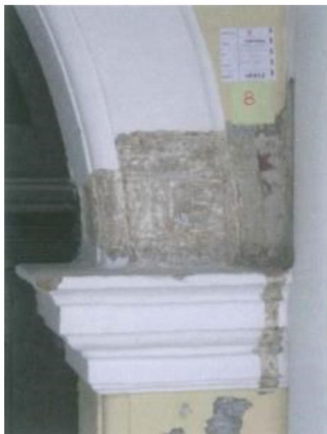
Slike 13 i 14: Sondiranje u okviru glavnog portala u altani sjevernog pročelja, prikaz izvornog kamena pješčara tretiranog vapnenim mlijekom te sloja cementne žbuke sa bojanim slojevima
