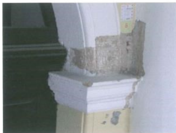
Slika 12: Kapitel stupa na zapadnoj strani altane, prikaz slojeva od crvenkastog „kamenog brašna“ preko cementne žbuke i završnih bijelo bojanih slojeva
