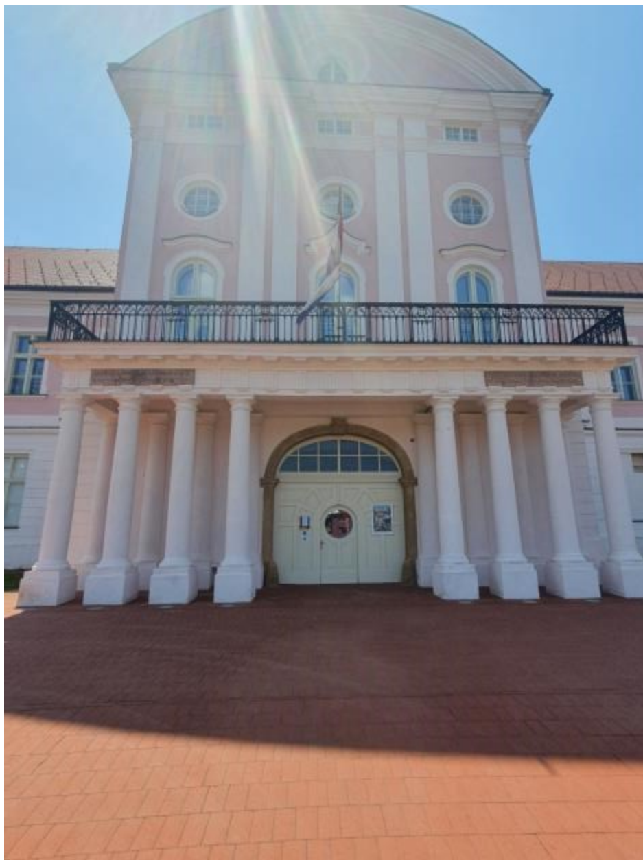
Slika 25: Središnji rizalit sjevernog pročelja nakon obnove
