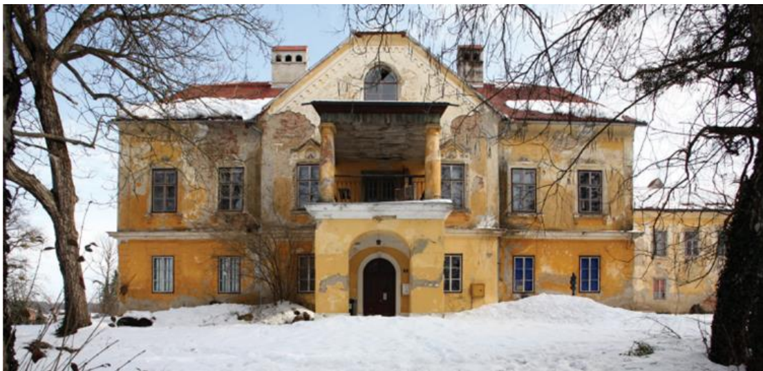
Slika 2: Pročelje glavnog krila, recentno stanje
