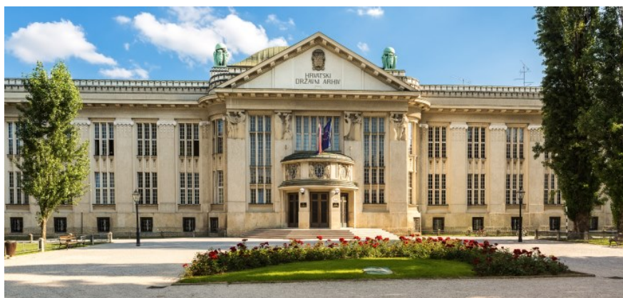
Slika 1: Matična zgrada Hrvatskoga državnog arhiva u Zagrebu
