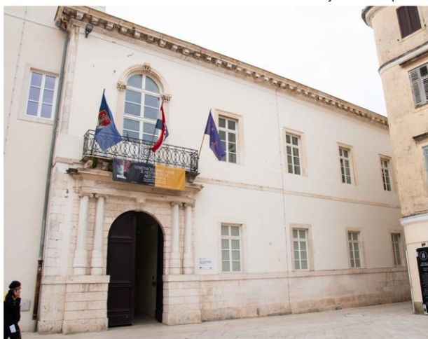
Pročelje Kneževe palače
