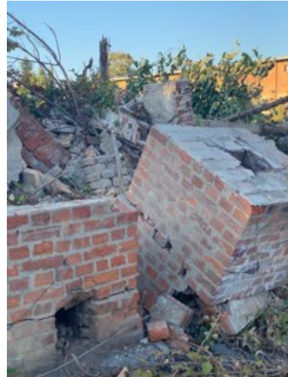
Fotografija 5. Prostor Bubare dan poslije rušenja kompleksa bivše tvornice. Vlastita fotografija (13. lipnja 2023. godine).
