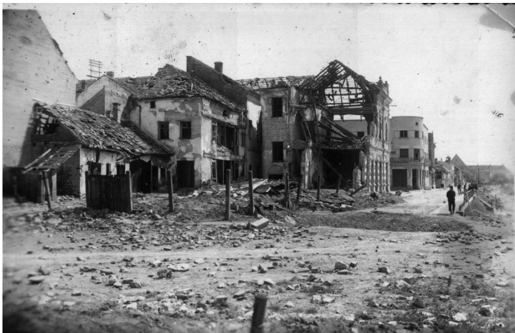
Slika 25. Kuća D' Elia, 1944.
