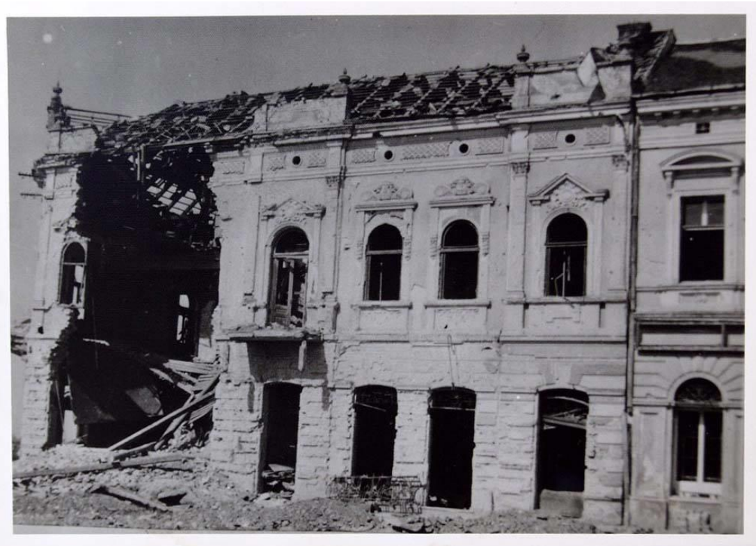
Slika 26. Kuća D' Elia, 1944.
