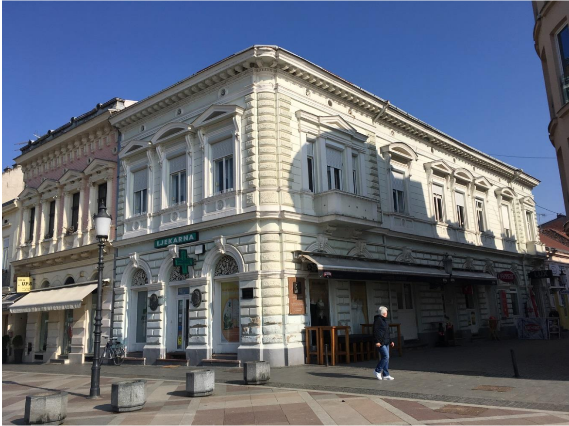
Slika 61. Kuća Radosavljević – Golubić
