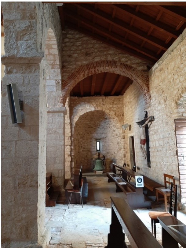
SLIKA 27. Zborna crkva sv. Marije Velike, poprečni luk na južnom zidu. Foto: M. Komar
