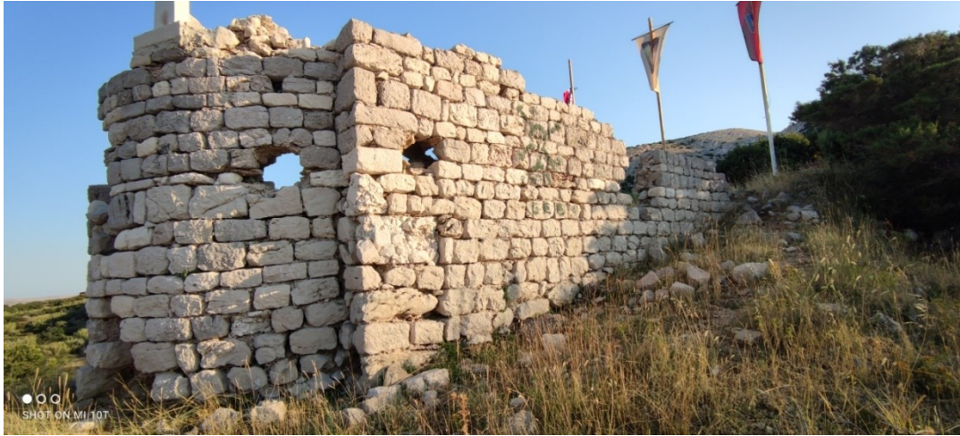
SLIKA 22. Crkva sv. Martina, pogled na SI zid. Foto: M. Komar.
