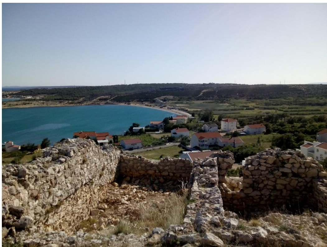
Slika 23: Pogled prema prostorijama u južnom dijelu utvrde. Fotografija: Đurđica Mirić
