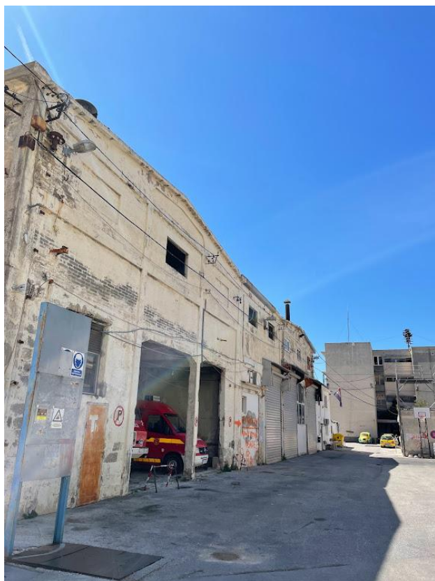
Slika 29. Zgrada DVD-a Dalmacija – Dugi Rat , nekoć u sklopu Tvornice karbida i ferrolegura, 2022.
