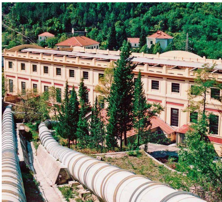
Slika 21. Hidroelektrana Kraljevac, današnje stanje.
