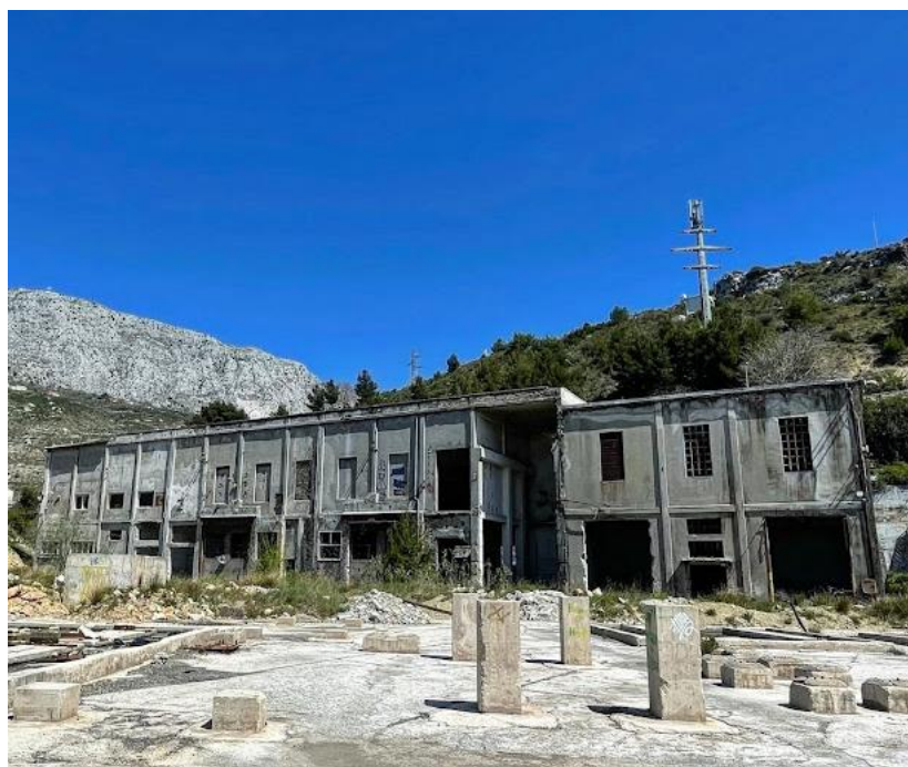
Slika 30. Napušteni industrijski objekt bivše Tvornice karbida i ferrolegura u Dugome Ratu, 2022.
