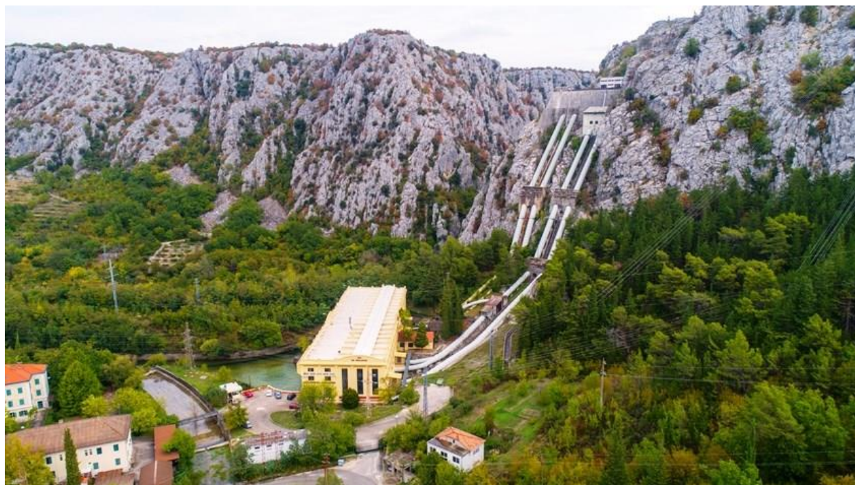
Slika 22. Hidroelektrana Kraljevac, današnje stanje.
