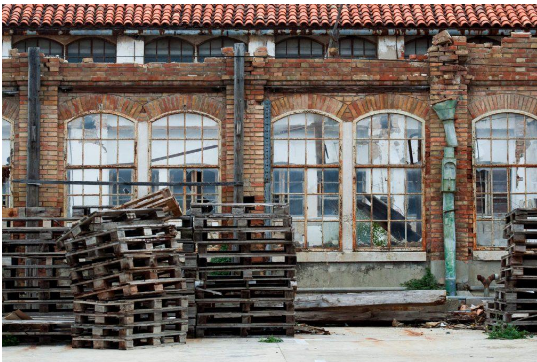
Slika 51. Nekadašnja tvornica Fratelli Mardesich/Neptun u Komiži na Visu, detalj dvorišnoga pročelja.
