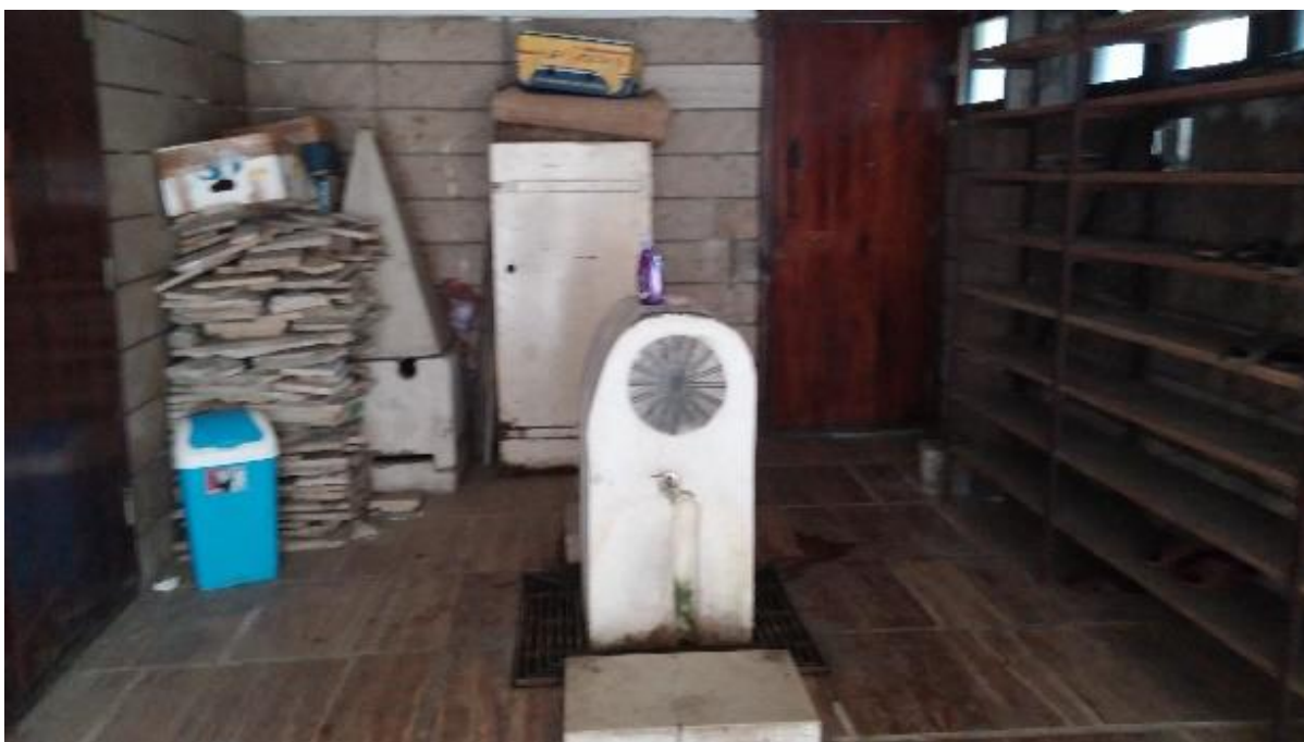
Kat. I. Sl. 8. Sklonjena obredna fontana, (2016.).
