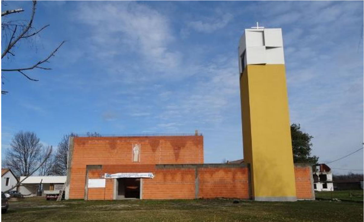
Kat. I. Sl. 43. Pročelje i zvonik crkve Sv. Franjo u Žeravcu. (2018.).
