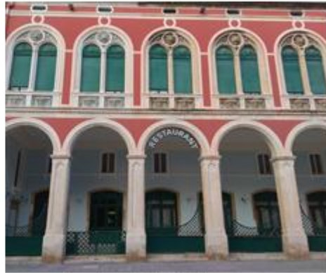
Zapadno krilo Prokurativa, detalj fasade, Trg Republike, Split, 1863.-1867.
