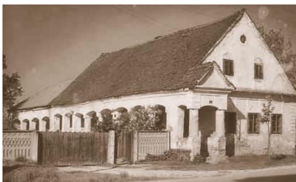
Slika 23. Fotografija zidanice jedinke s boltanim trijemom, Hlebine, danas srušena (foto-arhiva D. Feletara, 1973.)
