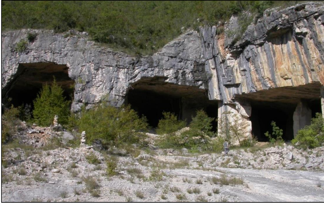
Slika 98. Napušteni podzemni kamenolom arhitektonskog kamena Sveti Stjepan (preuzeto iz MIKO I DR. 2013, 104).
