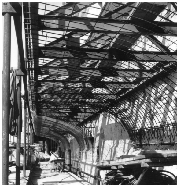
Slika 28. Nosači holkelā s lunetama i susvodnicama izrađeni u sklopu radova sedamdesetih i osamdesetih godina 20. stoljeća
