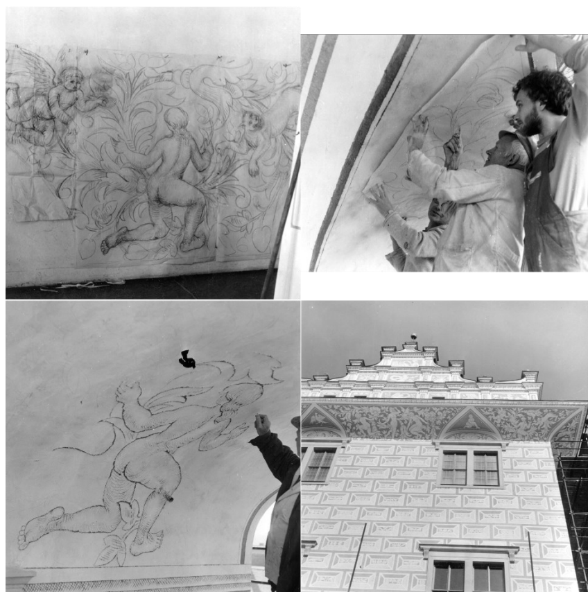
Slika 29. Proces izrade novih holkela s lunetama i susvodnicama
