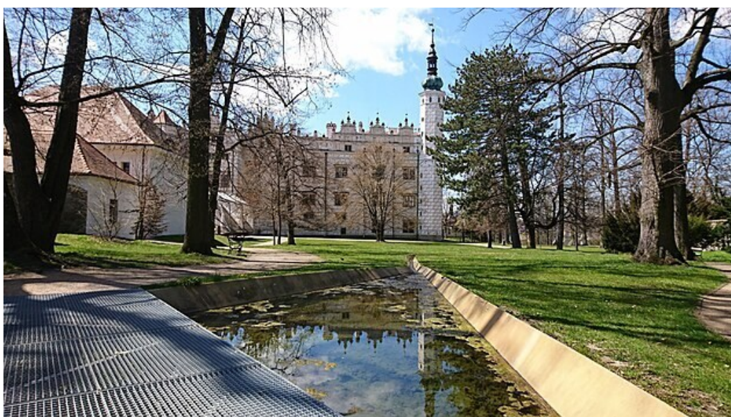
Slika 46. Korito potoka izrađeno od stakloplastike
