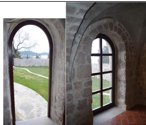
sl.38. i 39. Otvori u romaničkom trijemu
