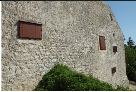
sl.13 Prozori na zgradi biskupije
