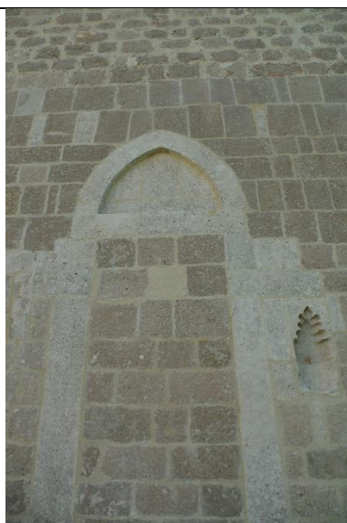
sl.31. Razlika u kamenu sjevernoga pročelja
