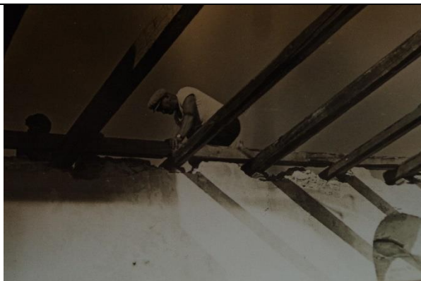
sl.27. Postavljanje krovišta
