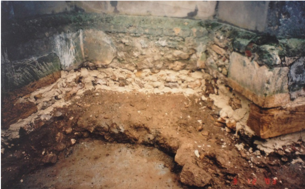
Slika 14: Temeljna konstrukcija crkve – iskop za potrebe drenaže, snimljeno u prosincu 2003. godine
