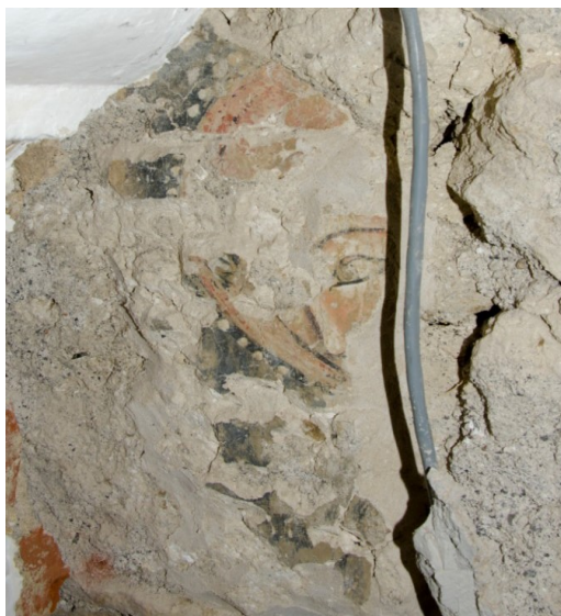
Slika 40: Otkriven fragment oslika sondiranjem na lijevom dijelu južnog zida drugog traveja
