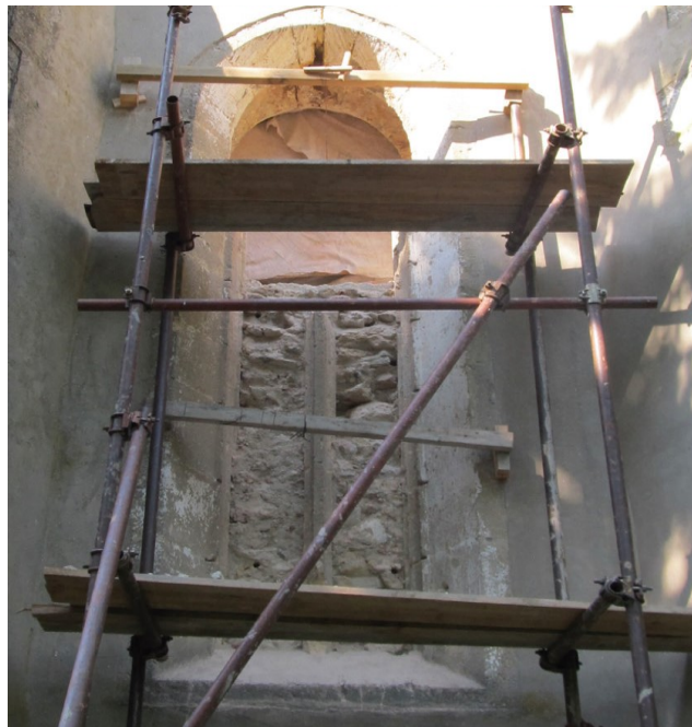
Slika 62: otvaranje kamene ispune središnjeg prozora svetišta za vrijeme radova
