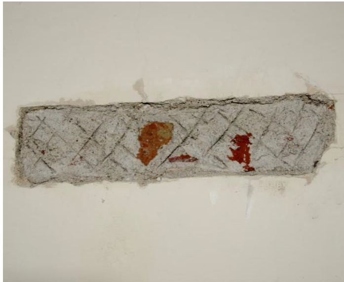
Slika 53: Komadići opeke utiskivani u svježi prvi sloj žbuke
