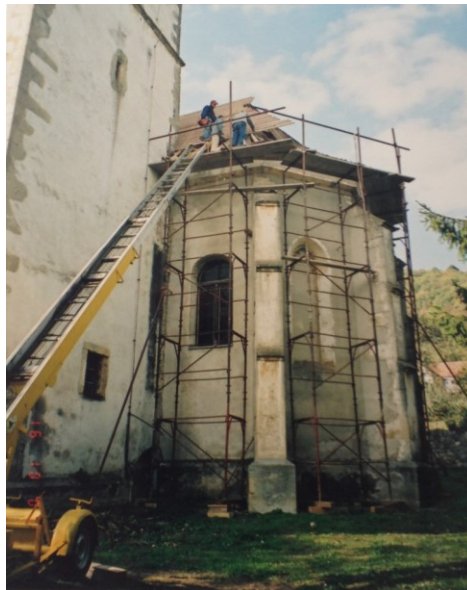
Slika 17: Radovi na krovštu svetišta 2006. godine
