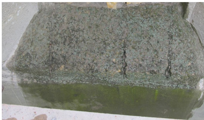
Slika 59: prozorska klupčica središnjeg prozora, mikroorganizmi koji degradiraju kamen
