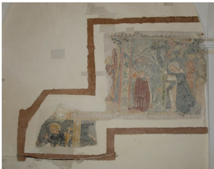
Slika 55: Ispuna utora oko oslika žrtvovanom žbukom
