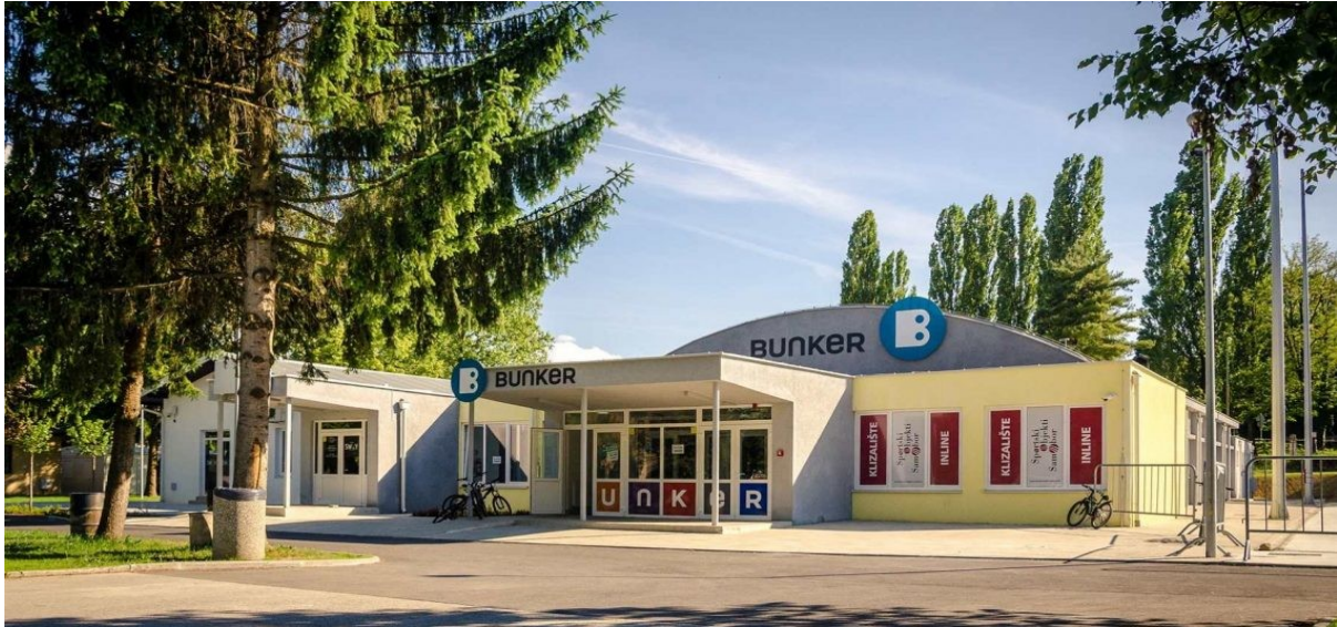
Slika 4. Bunker izvana. (izvor: Radio Samobor, preuzeto s: https://www.radiosamobor.hr/2021/04/27/samoborski-bunker-slavi-4-rodendan/ , 21.06.2022.)
