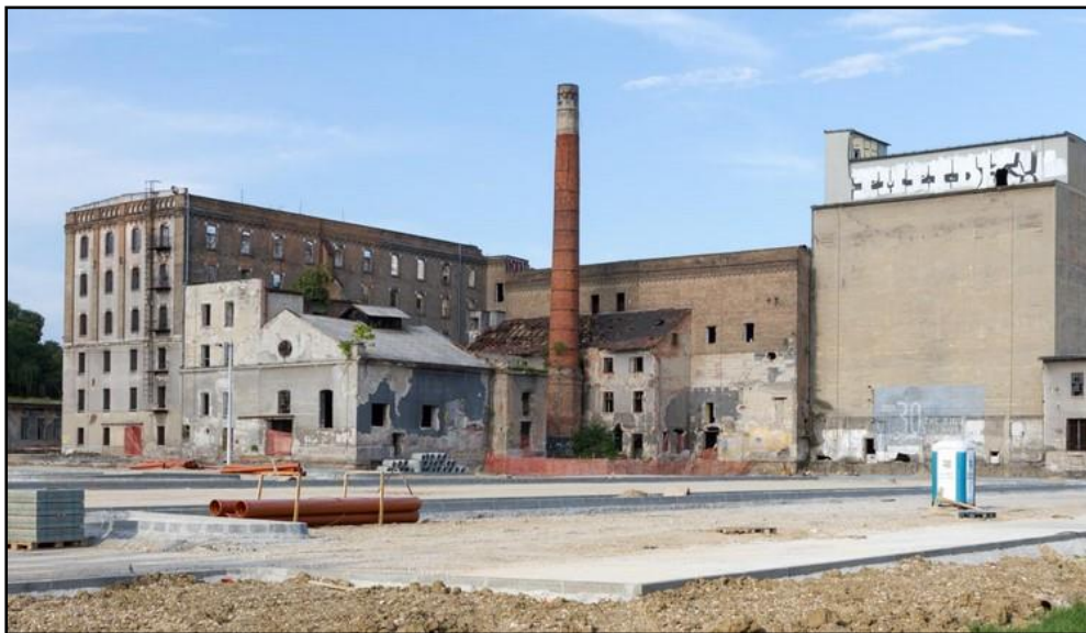
Sl. 53. Smještaj i izgled dimnjaka prije rušenja
