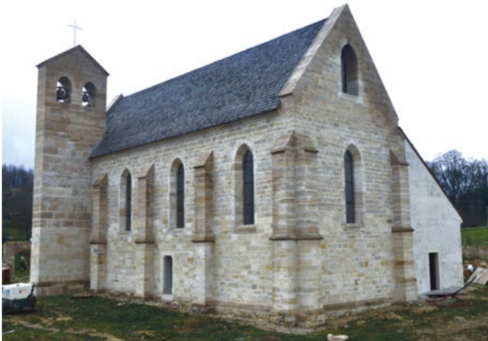
Crkva Uznesenja Blažene Djevice Marije u Gori (Miletić, Drago i Valjato Fabris, Marija. "Rekonstrukcija templarskog sloja župne crkve Uznesenja BD Marije u Gori." Portal: godišnjak Hrvatskoga restauratorskog zavoda 5. (2014), str.61)
