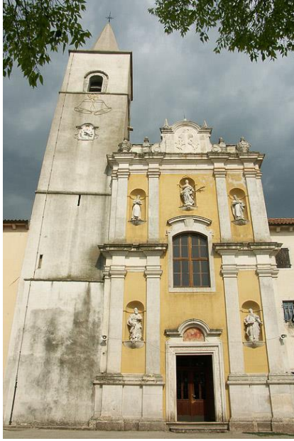
Slika 18. Pročelje crkve sv. Petra u Šumi
